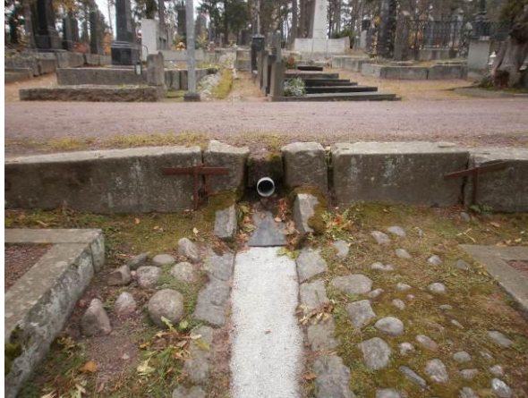
Kuva 24. Näsinmäellä sadevesi kulkee vaihtelevakuntoisissa avo-ojissa.
