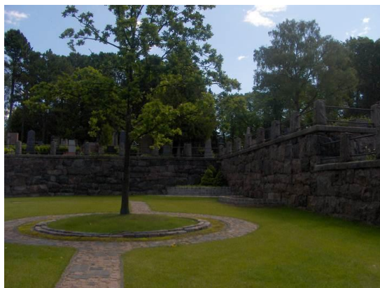
Kuva 7. Hietaniemen terassikortteleiden muurit on tehty paikalla louhitusta kivistä.
