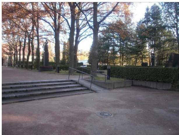
Kuva 9. Tämä portaiden ja luiskien yhdistelmä Hietaniemessä ei noudata rakennusmääräyksiä aikaisen rakentamisajankohdan takia, mutta se toimii esimerkkinä yhdistämisen ajatuksesta.
