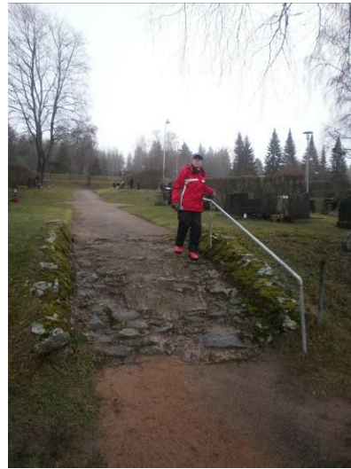
Kuva 18. Viime vuosina hautausmaalle on rakennettu yhdellä käsijohteella varustettuja portaita. Luiskia on useampia, mutta niistä vain yksi on kivipintainen.
