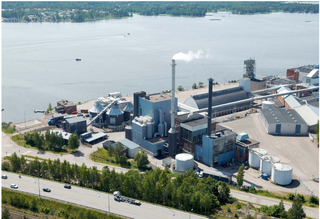
(Kuva1) Hovinsaaren voimalaitos. Toimii Kotkan Energia Oy:n päätuotantolaitoksena (3).
