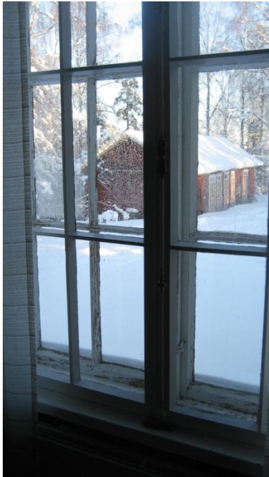
Kuva 20. Ikkuna sisäpuolelta (Talka 2012)
