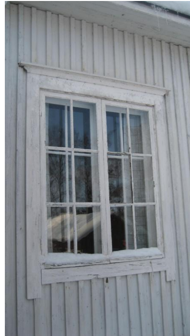
Kuva 21. Ikkuna ulkopuolelta (Talka 2012)
