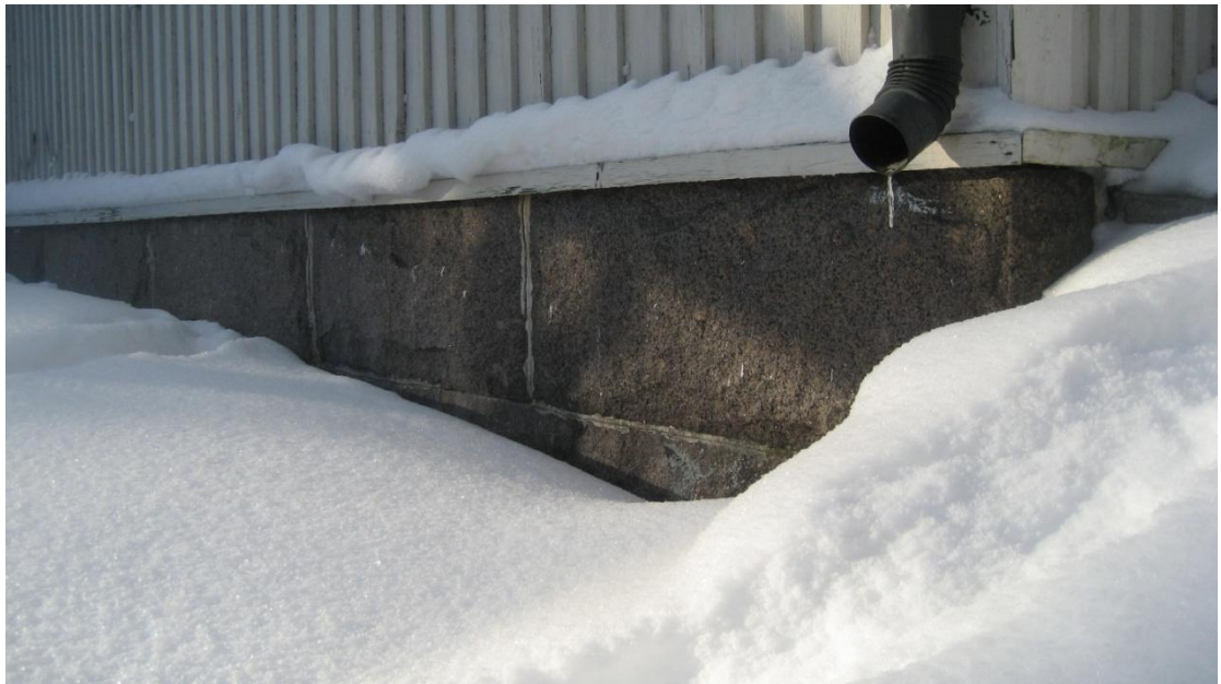
Kuva 17. Rakennuksen graniittiperustus (Talka 2012)
