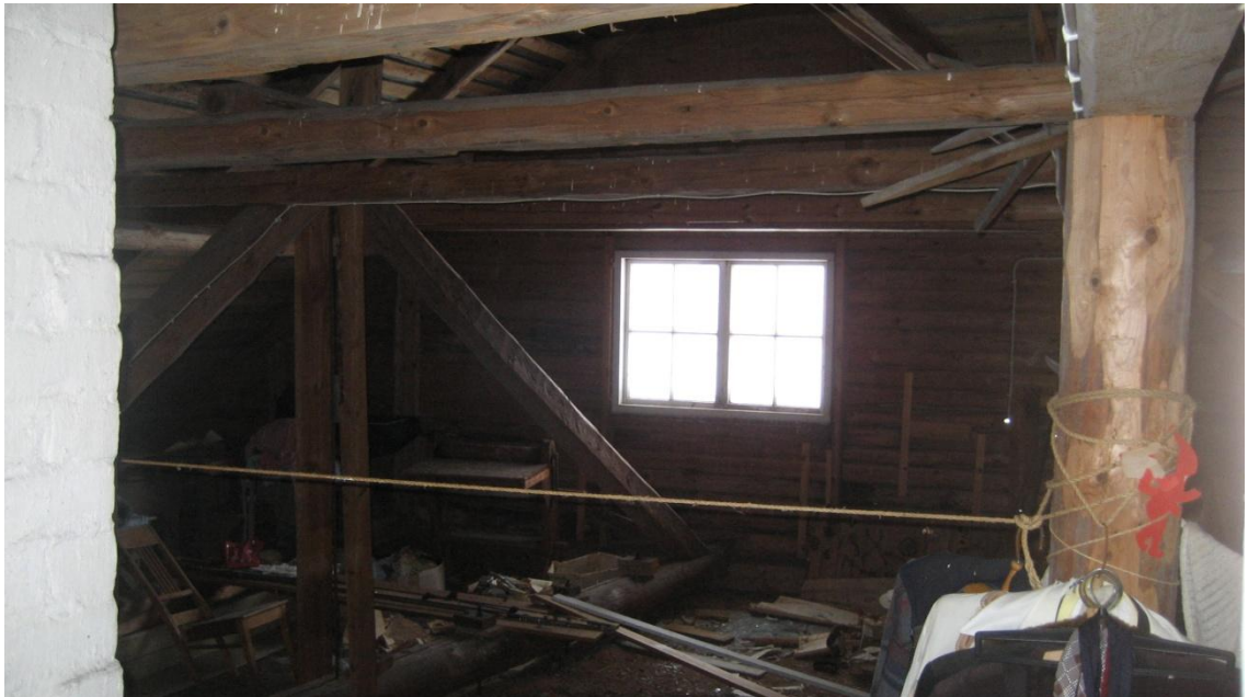
Kuva 19. Rakennuksen ullakkoa ja sen rakenteita (Talka 2012)
