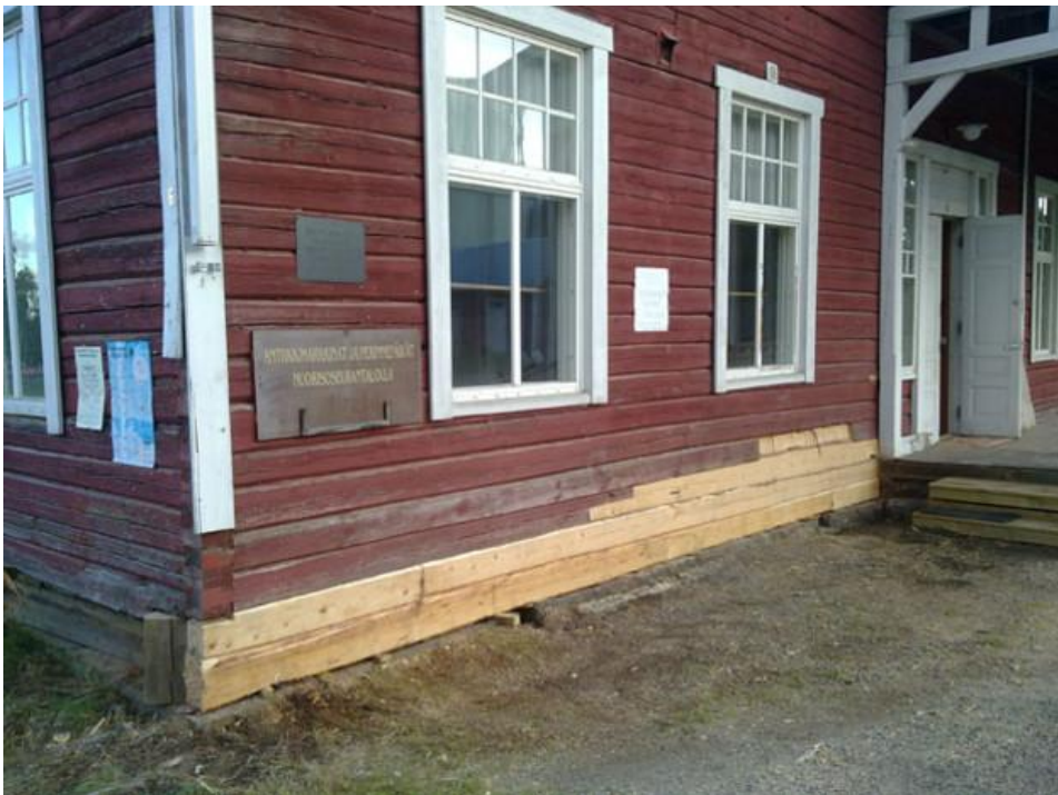
Kuva 4. Muuramen nuorisoseurantalon korjattua hirsiseinää (Muuramen Nuorisoseura)
