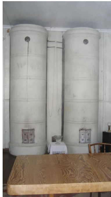
Kuva 27. Luokkahuoneen pönttöuunit (Talka 2012)
