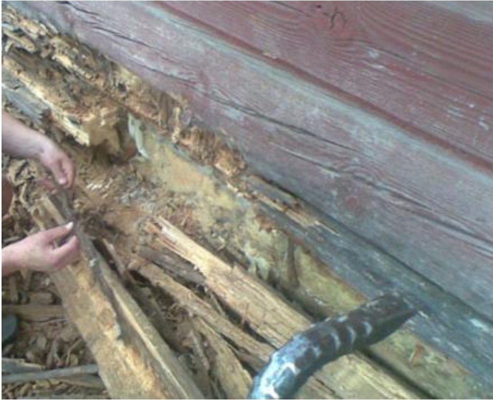
Kuva 3. Muuramen nuorisoseurantalon lahonneet alimmat hirsikerrat (Muuramen Nuorisoseura)
