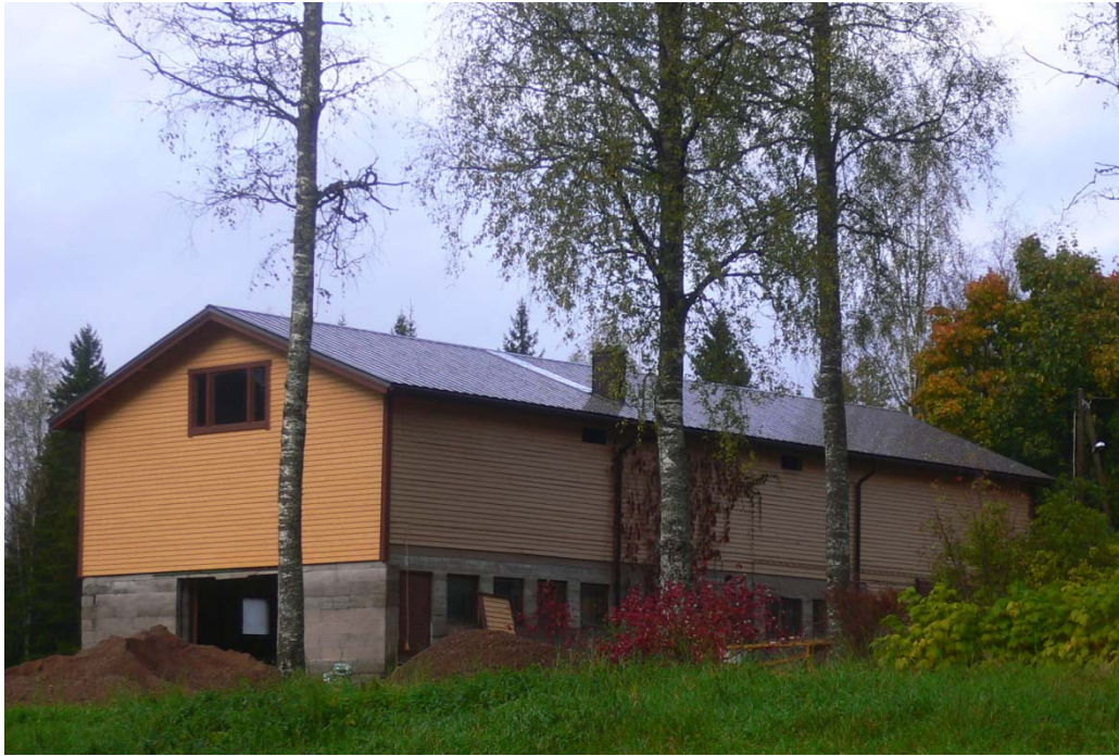
Kuva 6. Esimerkkikohteen rakennustyöt ovat käynnissä (Mentula 2010)
