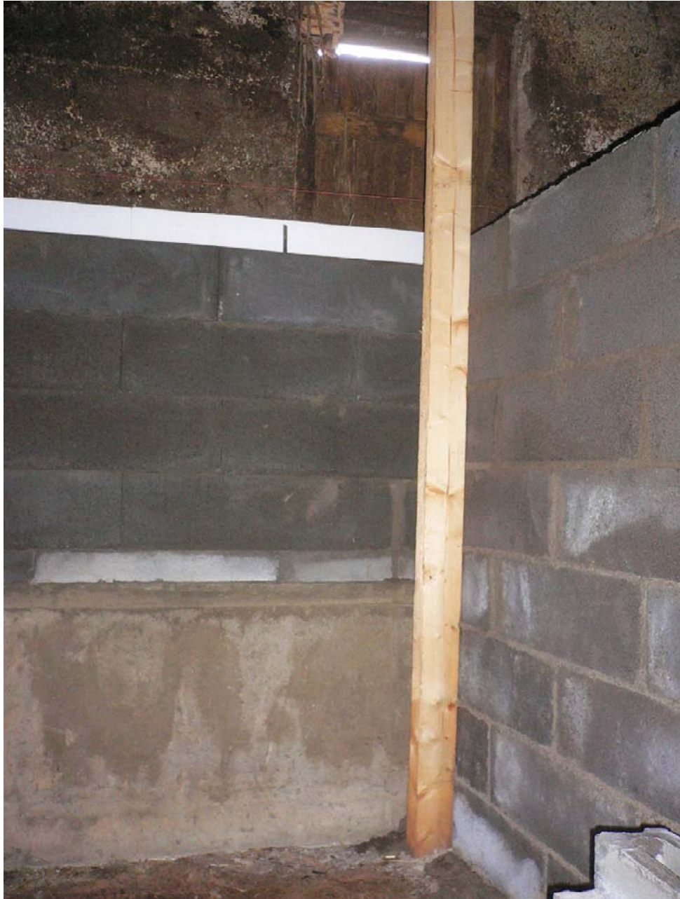
Kuva 7. Kuvassa näkyy pohjoispuolen seinä, jossa lisäanturan päälle on muurattu 100 mm valuharkko. Kuvassa oikealla näkyy kantavan väliseinämuuraus. (Mentula 2010.)
