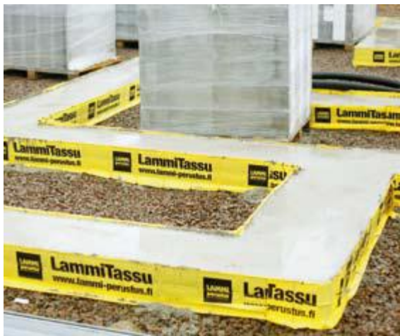
Kuva 16. LammiTassu-valmisanturamuotti valettuna (36)
