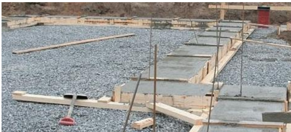
Kuva 7. Vanerimuottiin valettu antura (20)
