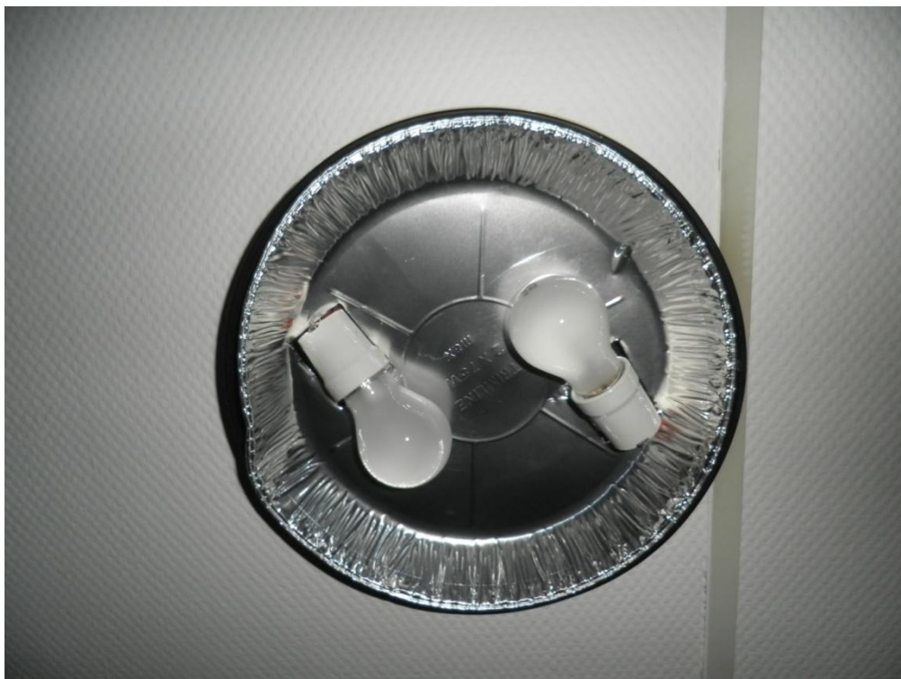
Kuvio 14. Valaistus on toteutettu yleisimmin 2 x 60 W hehkulampuilla ja vanhoilla, sumeilla valaisinkuvuilla.
