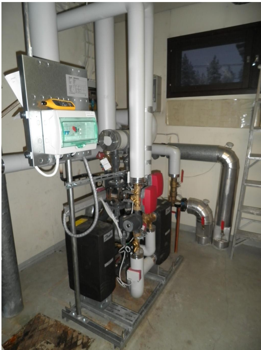
Kuvio 12. A-talossa sijaitseva lämmönjakokeskus
