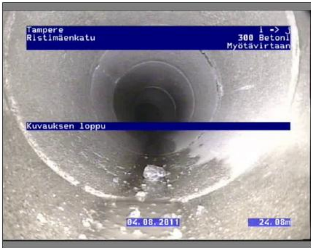
KUVA 17 TV-kuvausta Ristimäenkadun hulevesiviemäristä (Kaivopumppu M. Kulmala Oy)
