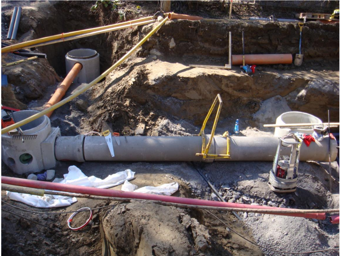
KUVA 16 Ristimäenkadun ja Leinikinkujan liittymän rakenteilla olevaa vesihuoltoverkostoa
