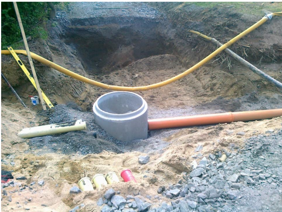
KUVA 6 Viemärin rakennuksen aikainen ohipumppaus
