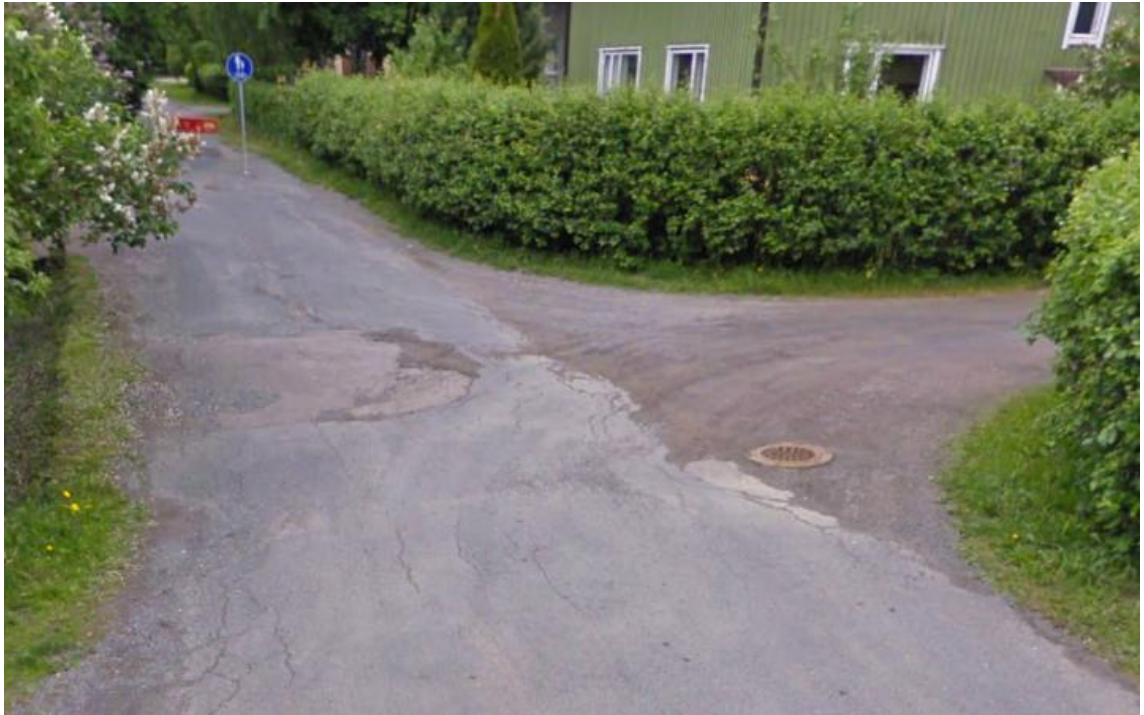
KUVA 15 Ristimäenkadun ja Leinikinkujan liittymä
