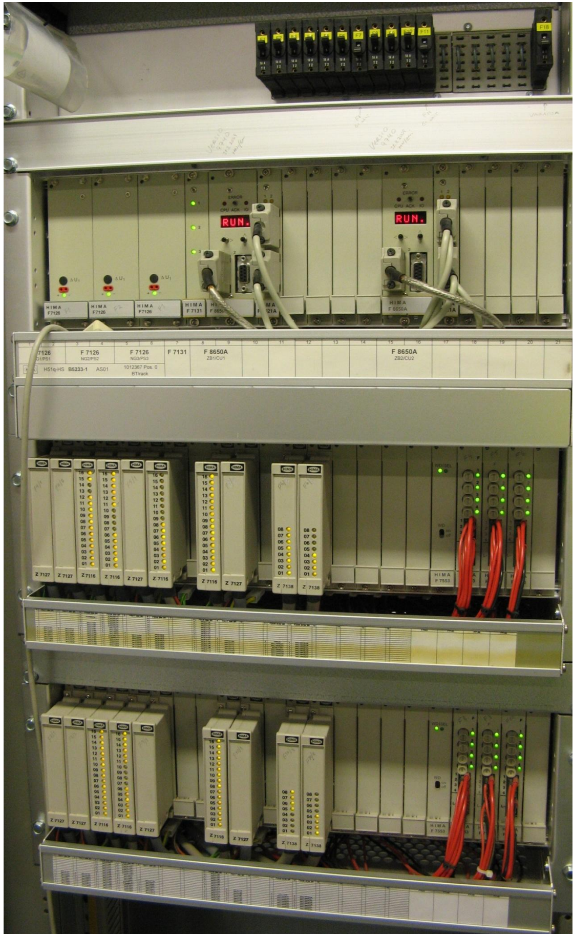
Kuva 9. Kattilan K7 turvalogiikkajärjestelmä. (6)
