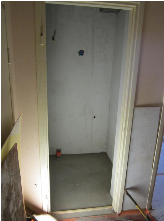
Kuva 4. Osittain valmistunut kylpyhuone.
