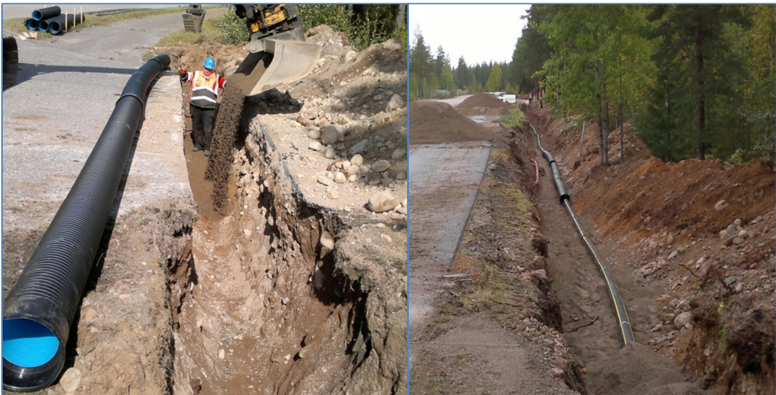
KUVA 21. Suojaputken asennus (NCC)
