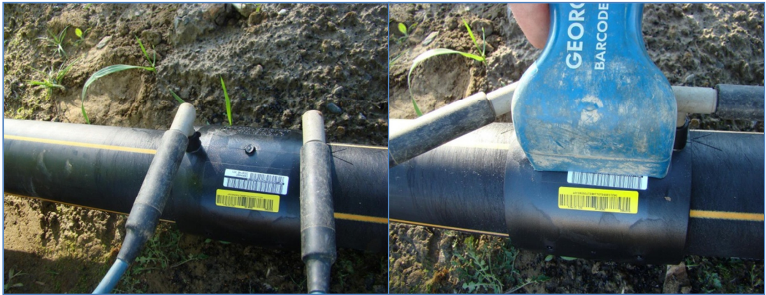
KUVA 19. Sähköjohtojen kiinnitys muhviin ja hitsausparametrien lukeminen
