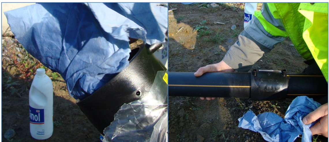
KUVA 18. Putkien ja sähkömuhvin puhdistus
