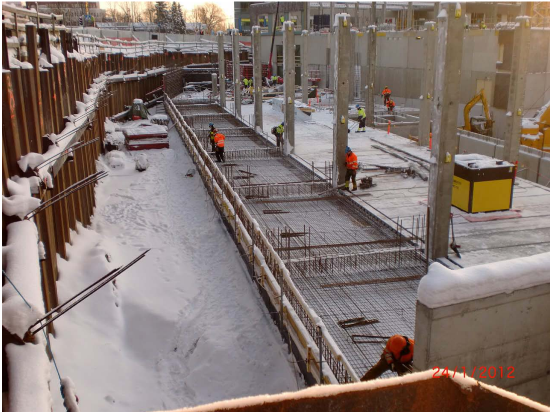
KUVA 14: Työturvallisuusselvityksessä kuvan työmaan siisteys koko projektin ajan sai kiitosta työntekijöiltä (Kuva: YIT Rakennus Oy).
