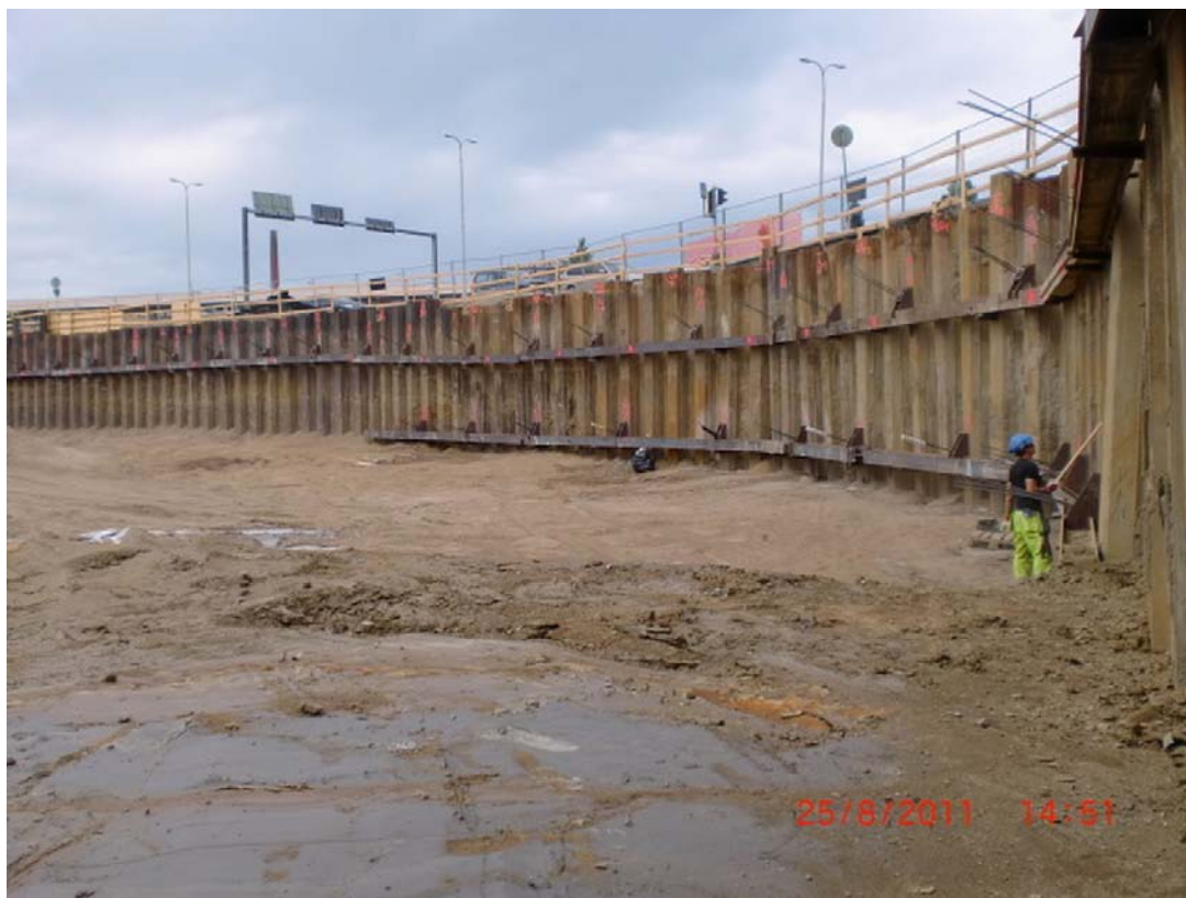
KUVA 12: Teräsponttiseinällä tuettu suurehko kaivanto. Kaivantojen tuenta tuo haasteita maanrakennustöihin (Kuva: YIT Rakennus Oy).
