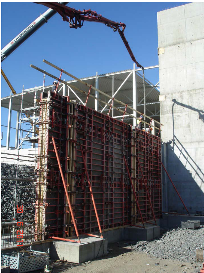
KUVA 13: Peri Trio -järjestelmämuotilla tehdyn tukimuurin valutyö käynnissä.
