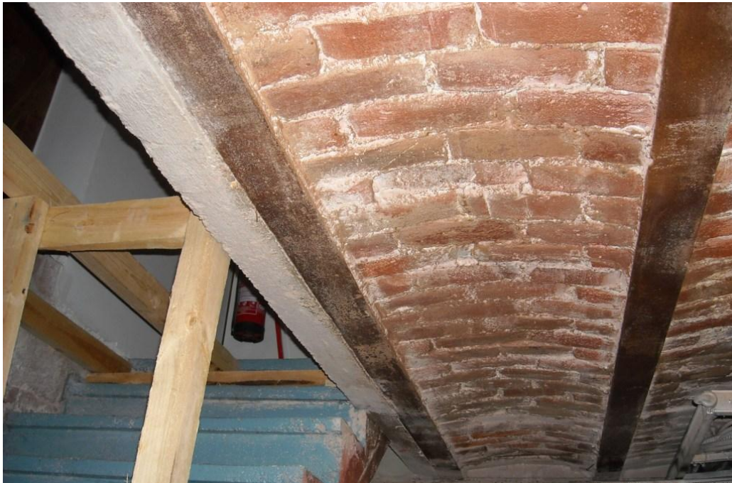
Kuva 30. Kellarikerroksen kappaholvikatto (Insinööritoimisto R J Heiskanen Oy, 2011)
