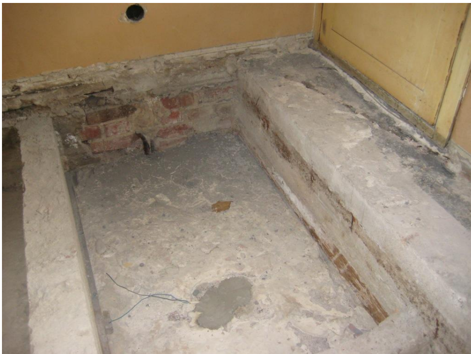
Kuva 37. Puhdistetut palkkivälit (Insinööritoimisto R J Heiskanen Oy, 2011)
