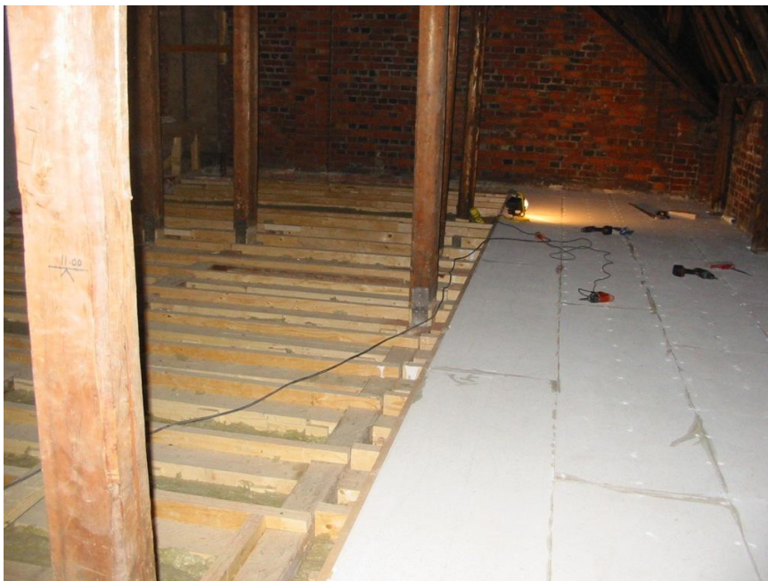
Kuva 35. Puuyläpohjan uusi lämmöneristys, oikaisukoolaus ja puukipsilevytyt (Insinööritoimisto R J Heiskanen Oy, 2005)
