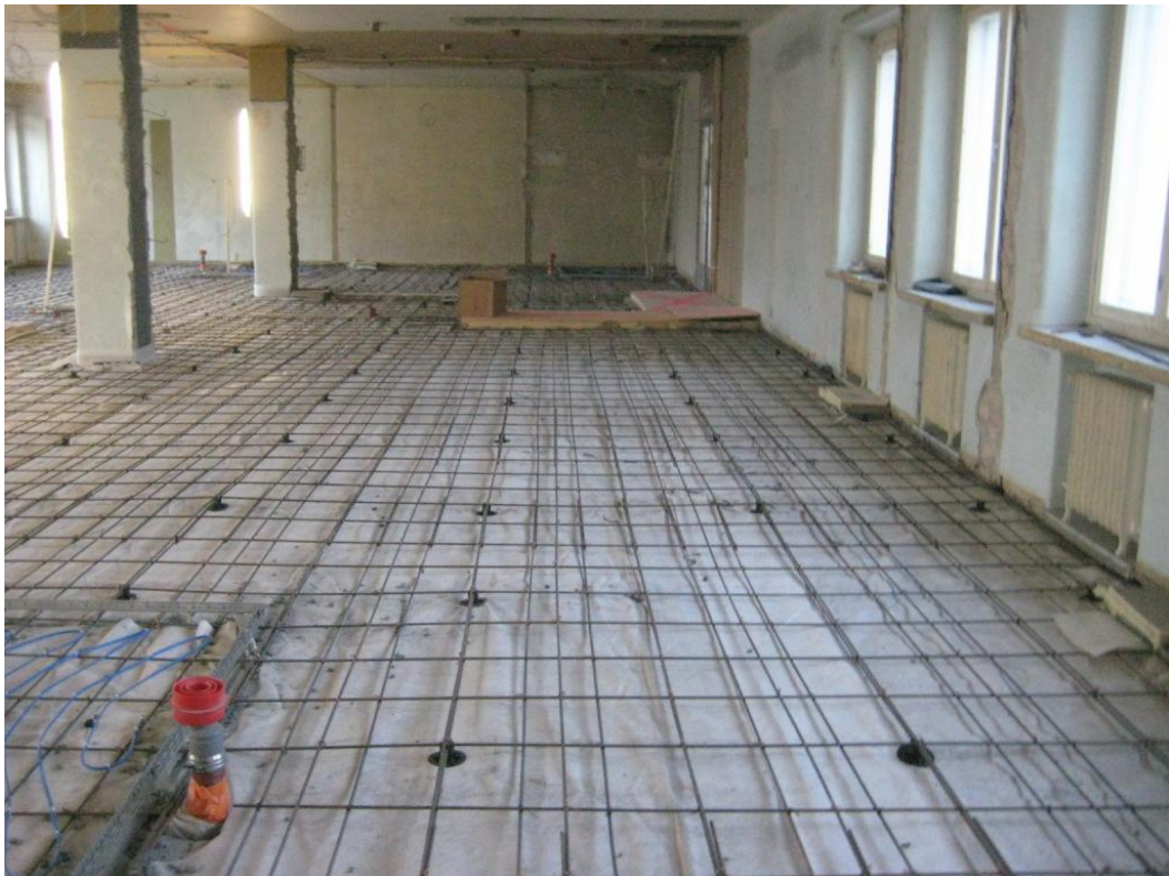
Kuva 38. Tulevan betonilaatan raudoitus ja suodatinkangas (Insinööritoimisto R J Heiskanen Oy, 2011)
