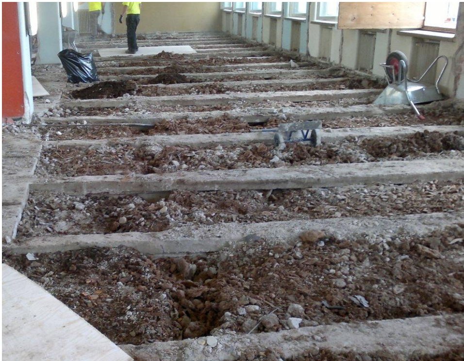
Kuva 36. Alalaattapalkiston mahapalkit sekä rakennusjäte- ja turvetäyttö. (Insinööritoimisto R J Heiskanen Oy, 2011)
