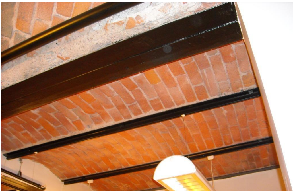
Kuva 31. Kunnostettu kappaholvirakenne (Insinööritoimisto R J Heiskanen Oy, 2011)
