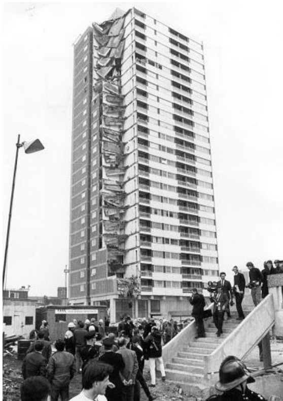
Kuva 7. Ronan Pointin kaasuräjähdyksessä vaurioitunut kerrostalo. [10.]
