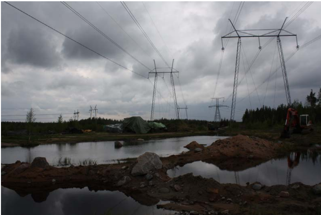
KUVIO 4. Suurjännitelinjat, vasemman puoleinen on voimakkuudeltaan 220 kV ja oikeanpuoleinen 400 kV (Raussi 2012). Kuva on otettu 28.5.2011.
