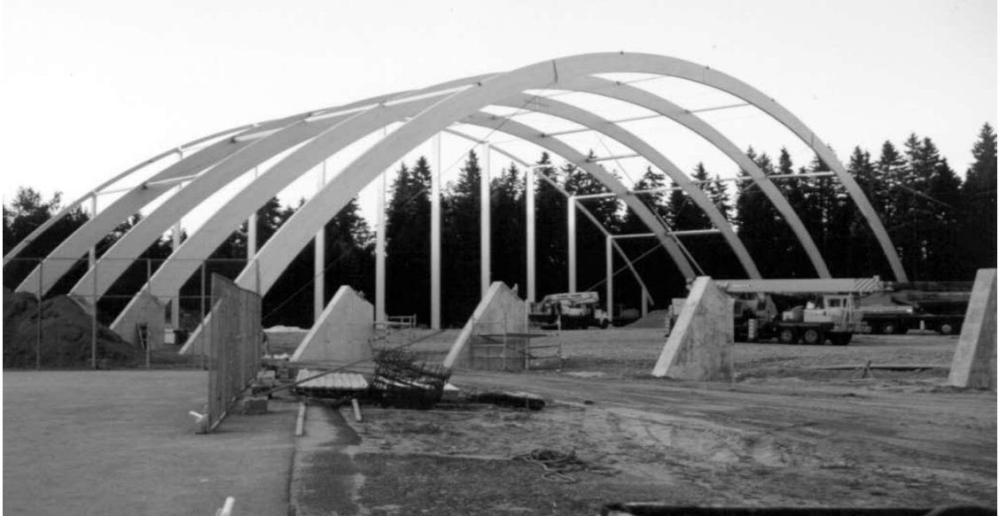
Kuva 6. Kaarirunkoisen urheiluhallin asennus käynnissä [10]
