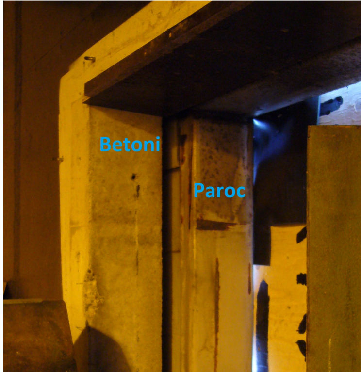
KUVIO 15. Saharakennuksen kaakkoispuolen seinän rakenne
