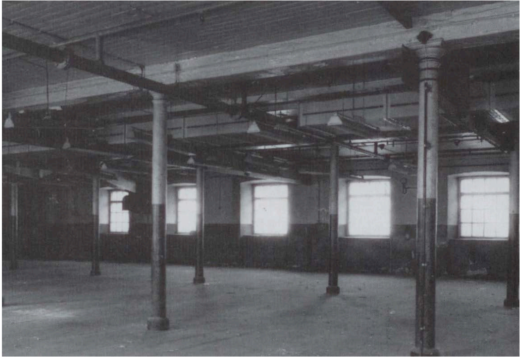
Kuva 7. Vuoden 1840 Fiskarsin konepajan valetut rautapylväät kannattavat tehtaan puista välipohjaa (Putkonen 4/1988: 20).
