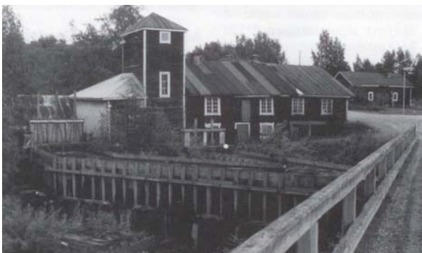
Liunan hirsirakenteinen voimalaitos.
