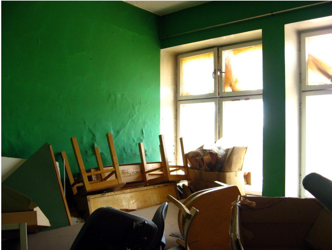
Kuva 12. Näkymä asuinrakennuksen 2. kerroksen huoneesta. (Kuva Mikko Helminen, 2006)
