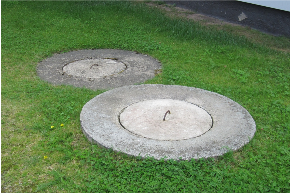
KUVA 18. Saostuskaivoja Oksatiellä (Kuva: Leena-Maria Törmälä 2011)
