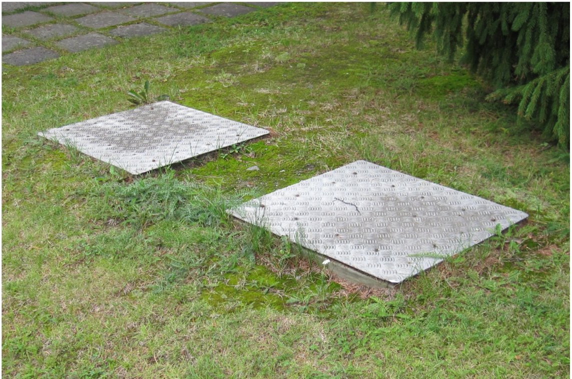
KUVA 19. Saostuskaivoja Isohakantiellä (Kuva: Leena-Maria Törmälä 2011)
