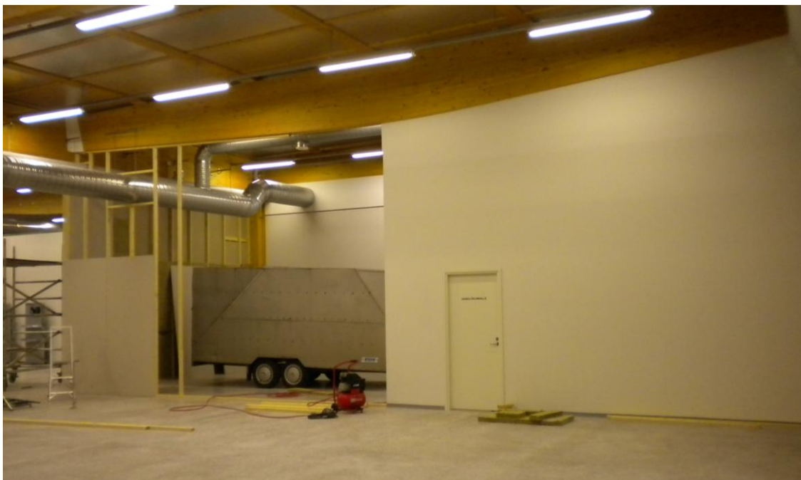
KUVA 2. Huollon laajentaminen rakennusvaiheessa 2010 syksyllä
