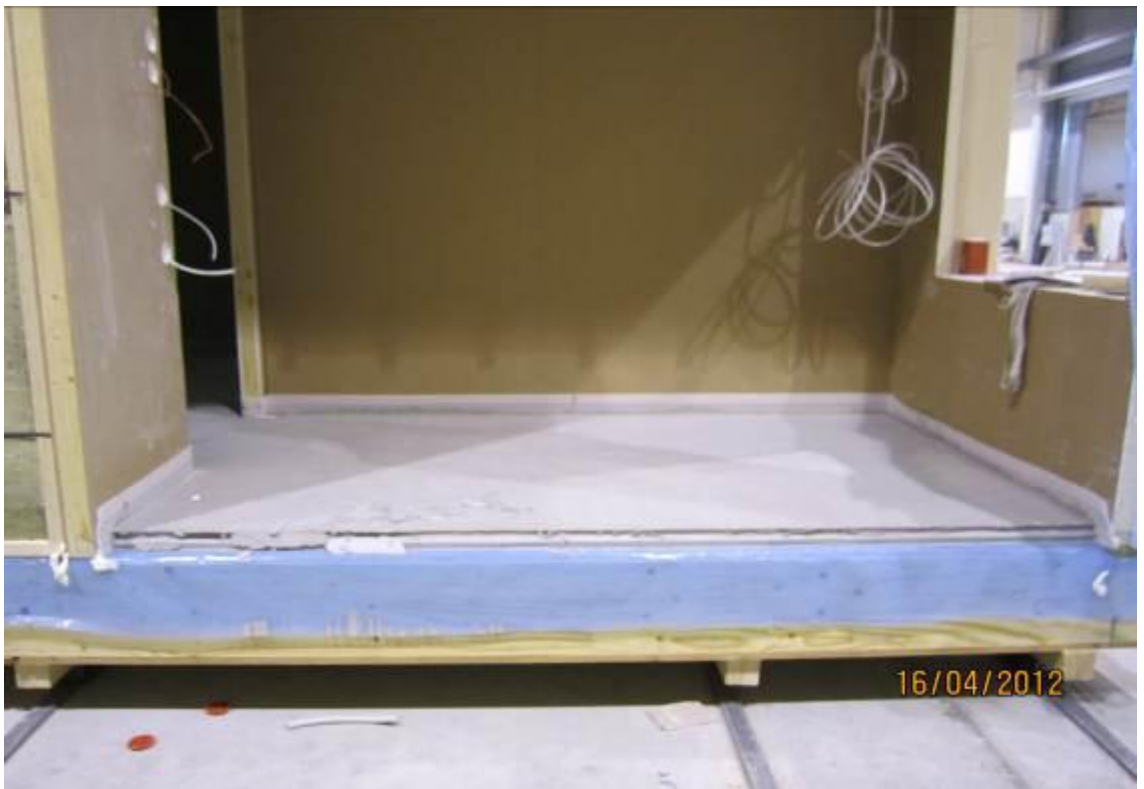
KUVA 12 Kuituvahvisteinen massalattia pumpattu, työvaihe 13 suoritettu
