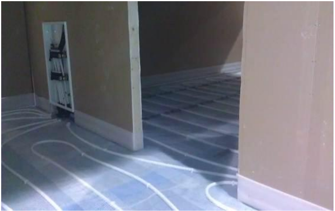
KUVA 11 Erotuskaistat, lattialämmitysputki ja vahvikeverkko asennettu kuiviin tiloihin työvaiheet 10, 11 ja 12 suoritettu
