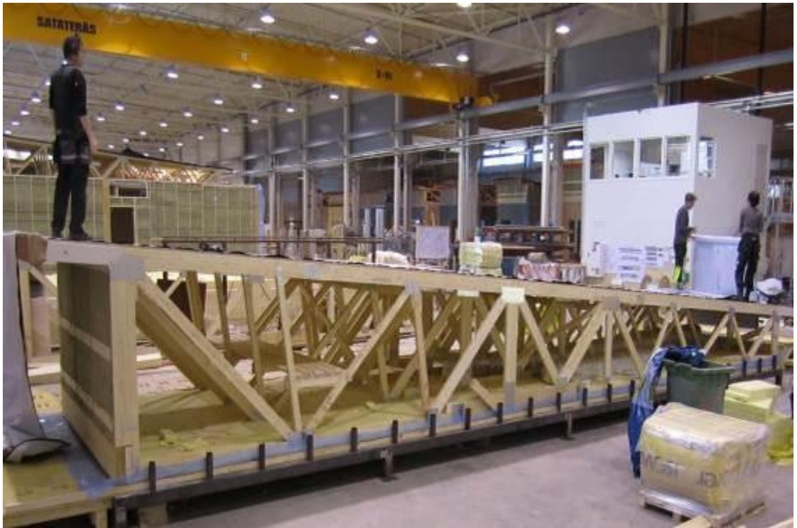
KUVA 9 Vesikattoelementti valmistumassa vesikattopöydällä
