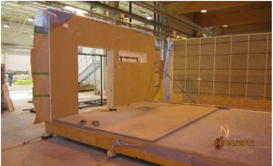
KUVA 6 Us-elementtien asennus, työvaihe 6
