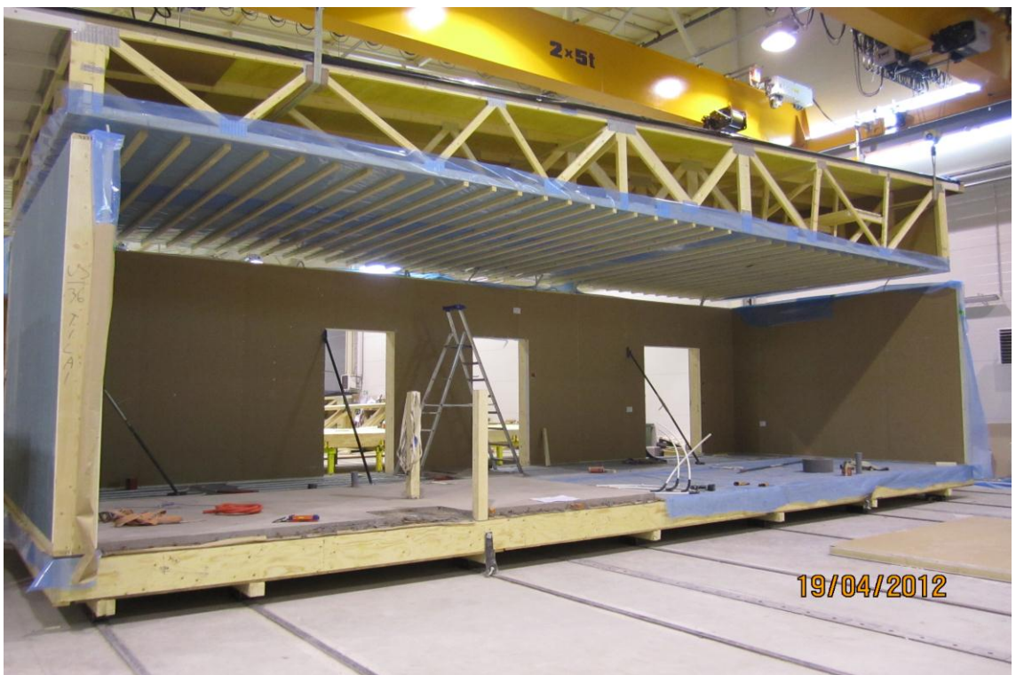
KUVA 10 Vesikattoelementin asennus, työvaihe 8
