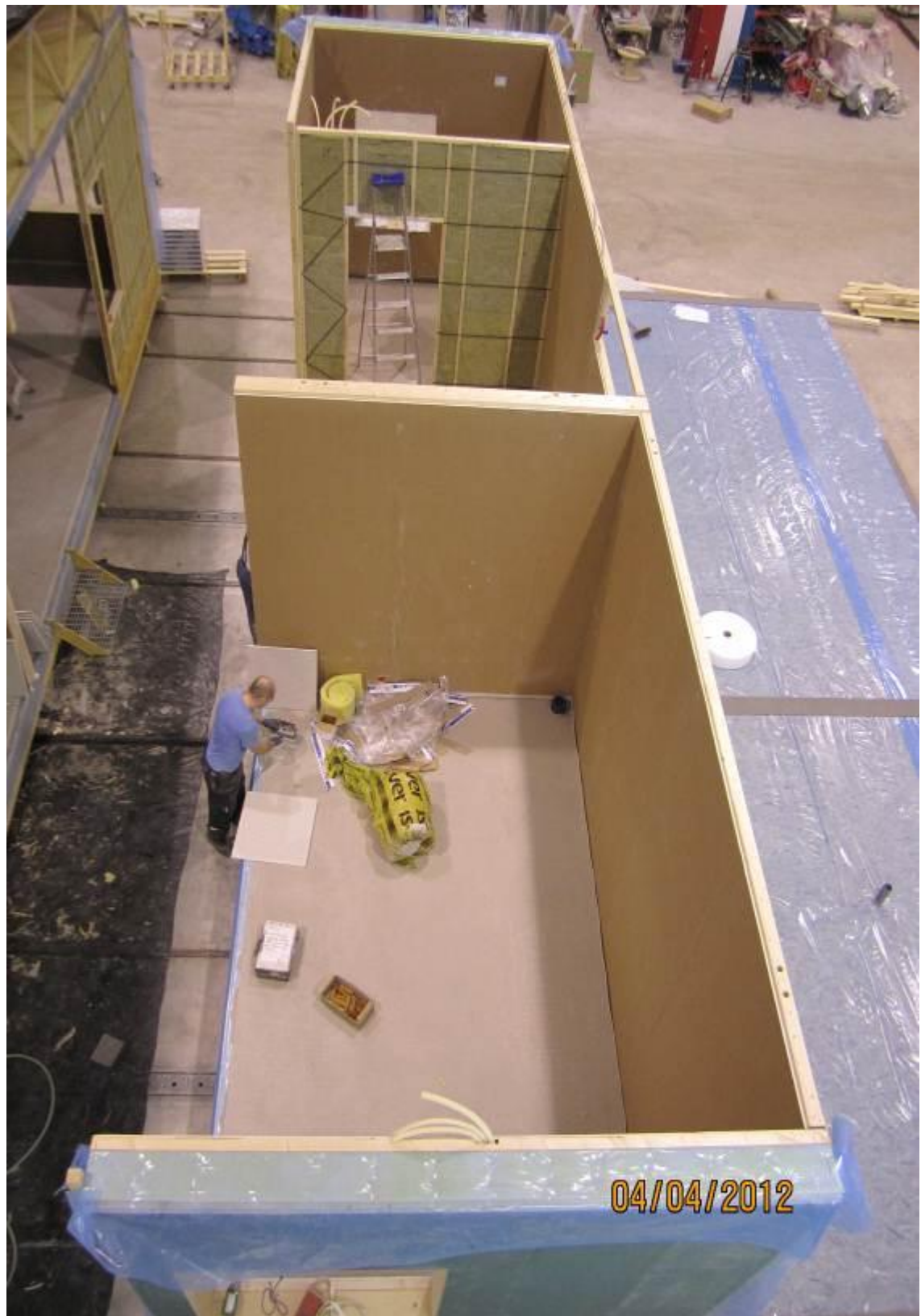
KUVA 8 Tilaelementin seinät pystytetyt, (työvaihe 7 suoritettu) odottaa vesikattoelementtiään
