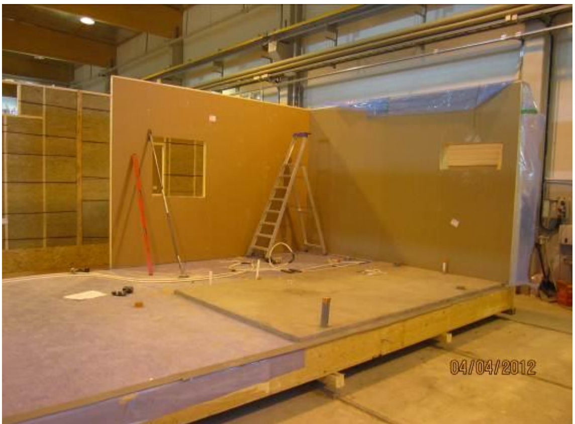
KUVA 7 Väliseinäelementtien pystytys, työvaihe 7
