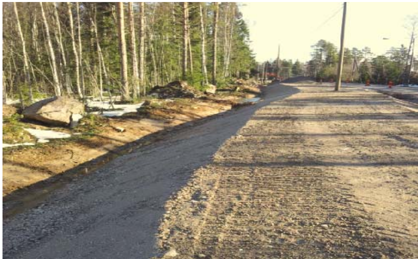
KUVA16. 3D-järjestelmällä rakennettua kevyen liikenteen väylää (Kuva: Ville Piironen)
