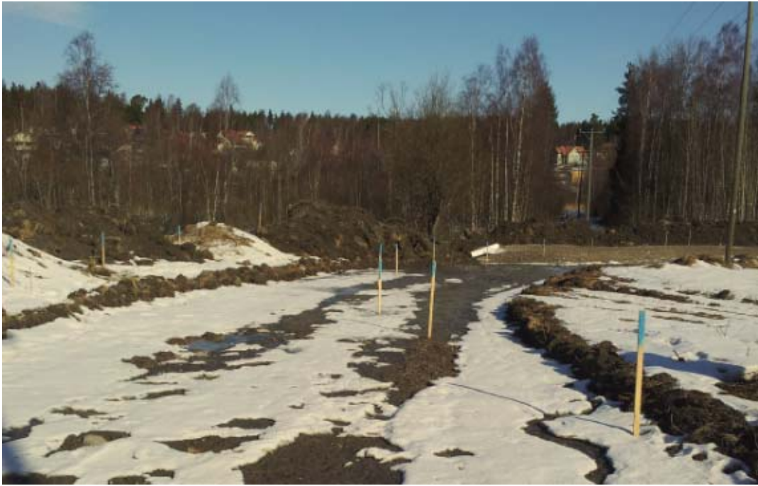
KUVA 11. Mittatikuilla merkittyä tielinjaa (Kuva: Ville Piironen)
