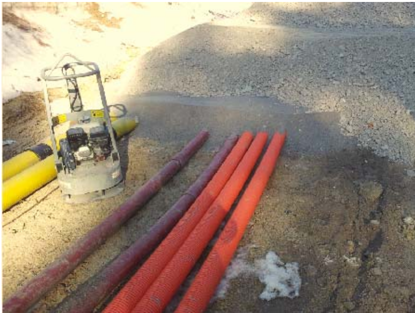
KUVA 22. Suojaputkien asennusta sekä rakennekerroksia (Kuva: Ville Piironen)
