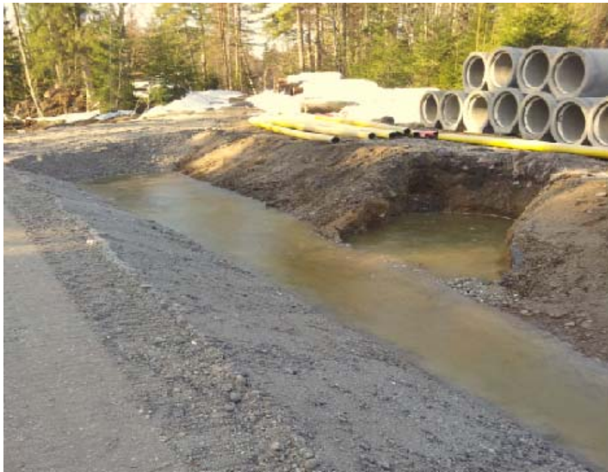
KUVA 15. 3D-järjestelmällä tehtyä luiskaa (Kuva: Ville Piironen)
