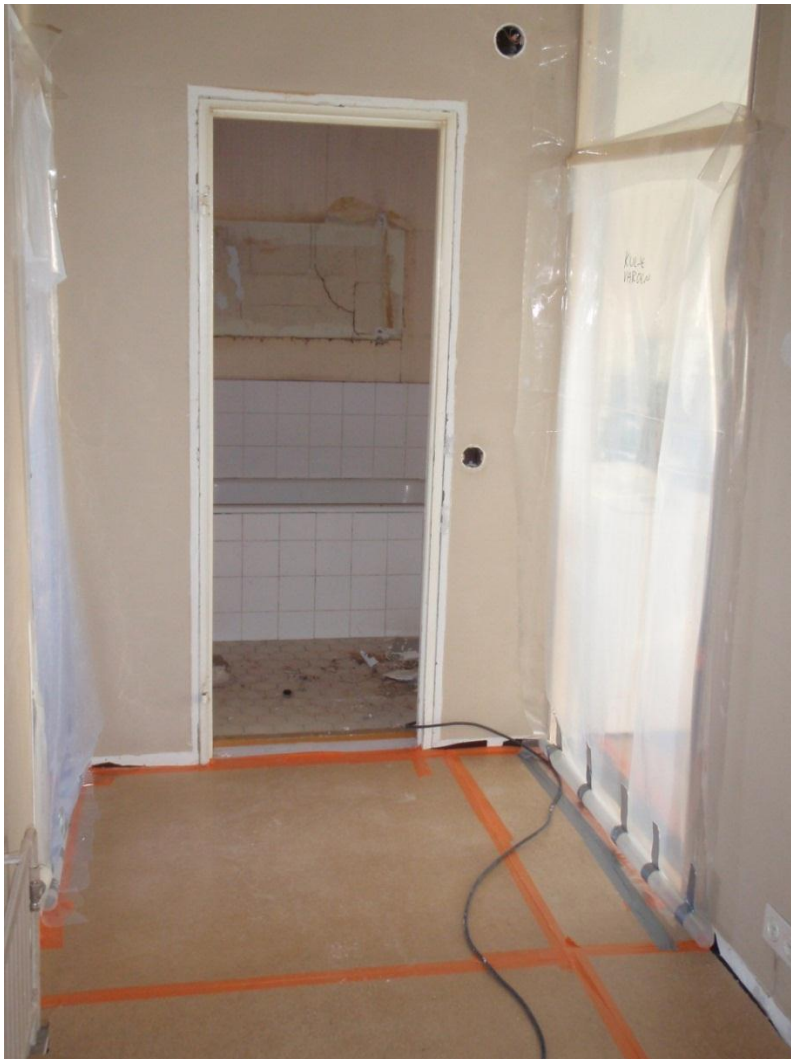
Kuva 3. Työalue eristetty muusta asunnosta
