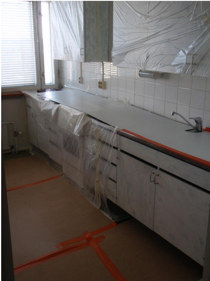
Kuva 4. Keittiö hyvin suojattuna
