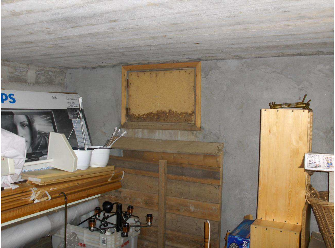
KUVA 6. Kellarista ulos vievä luukku sisältäpäin kuvattuna
