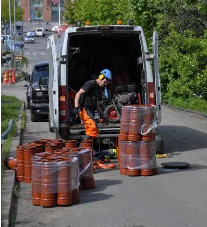
KUVA 8. MaxiLine -pätkäsujutusputkia (NRG International)
