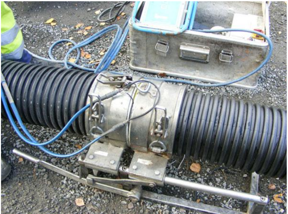
KUVA 2. Flexoren-putket hitsataan yhteen SWJ-menetelmällä. (NRG International)
