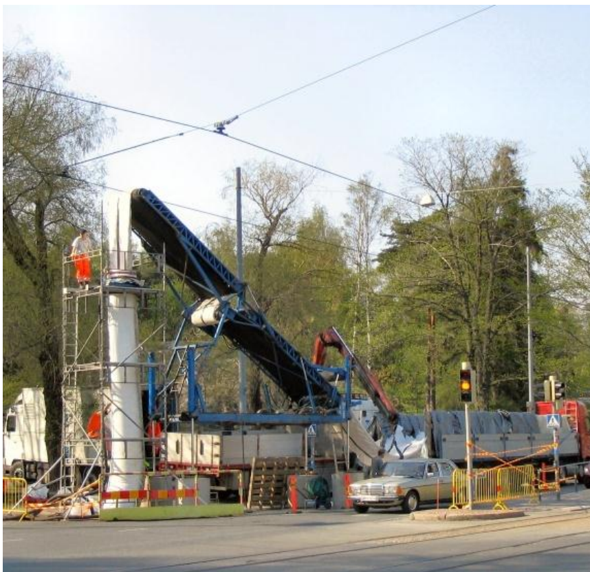
KUVA 9. Sukkasujutuskalustoa, asennusteline ja syöttöputki (NCC)
