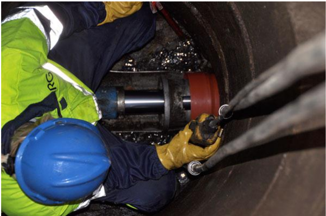
KUVA 7. Työntölaite ja putki (NRG International)
