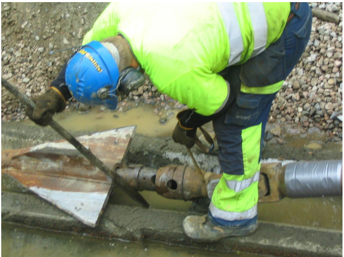
KUVA 14. Leikkuri kytetään aventimeen (Sujutek)
