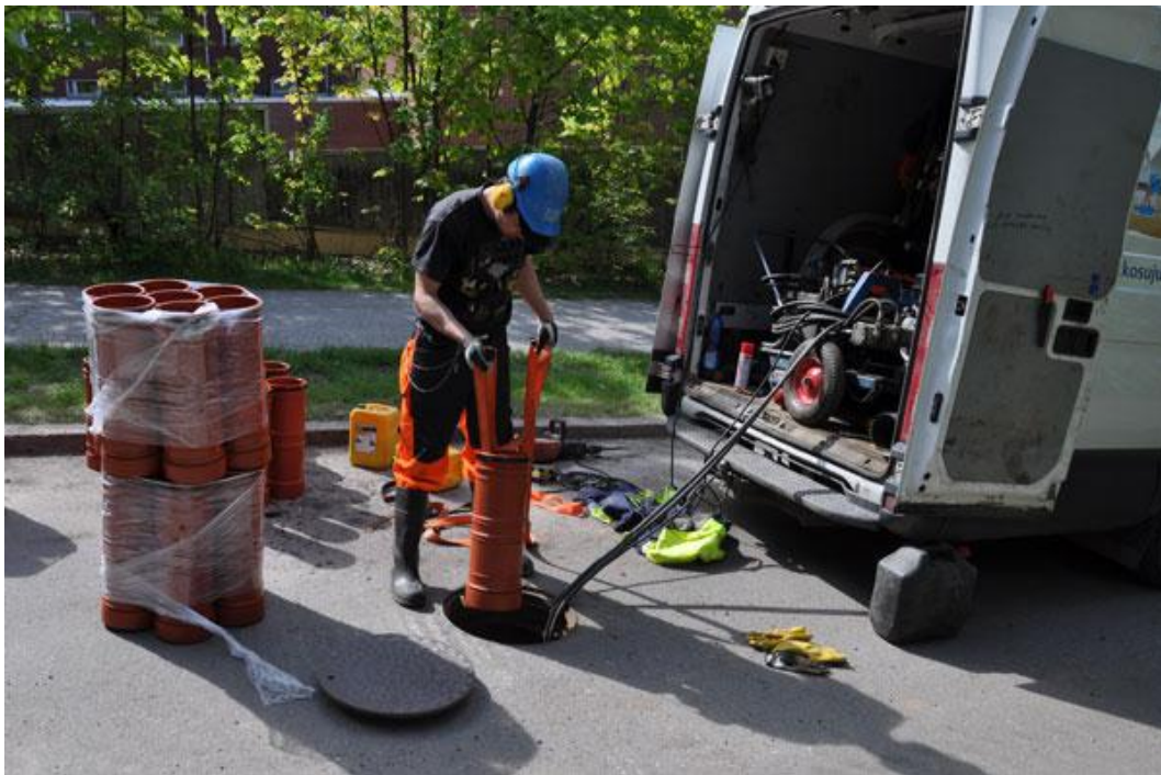
KUVA 6. Pätkäsujuutusputket asennetaan kaivon kautta (NRG International)
