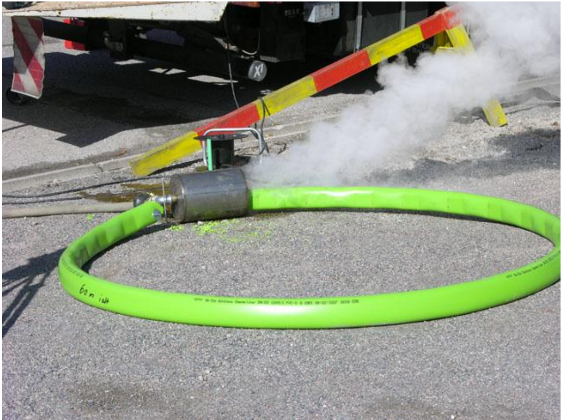
KUVA 4. Putken esilämmitys (NRG International)
