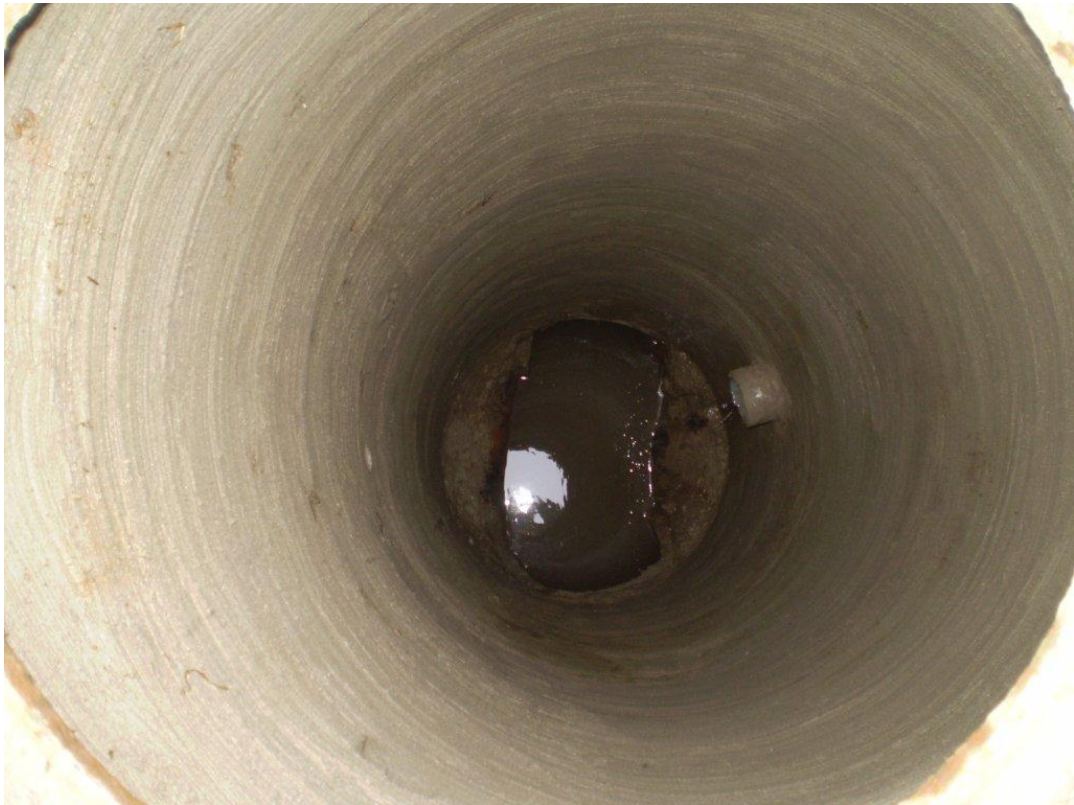
KUVA 16. Ruiskubetonoitu kaivo (NCC)
