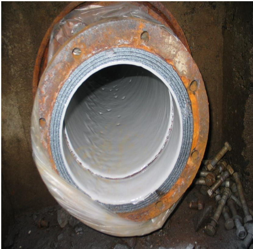
KUVA 15. PU-Liner -menetelmällä saneerattu putki (NCC)
