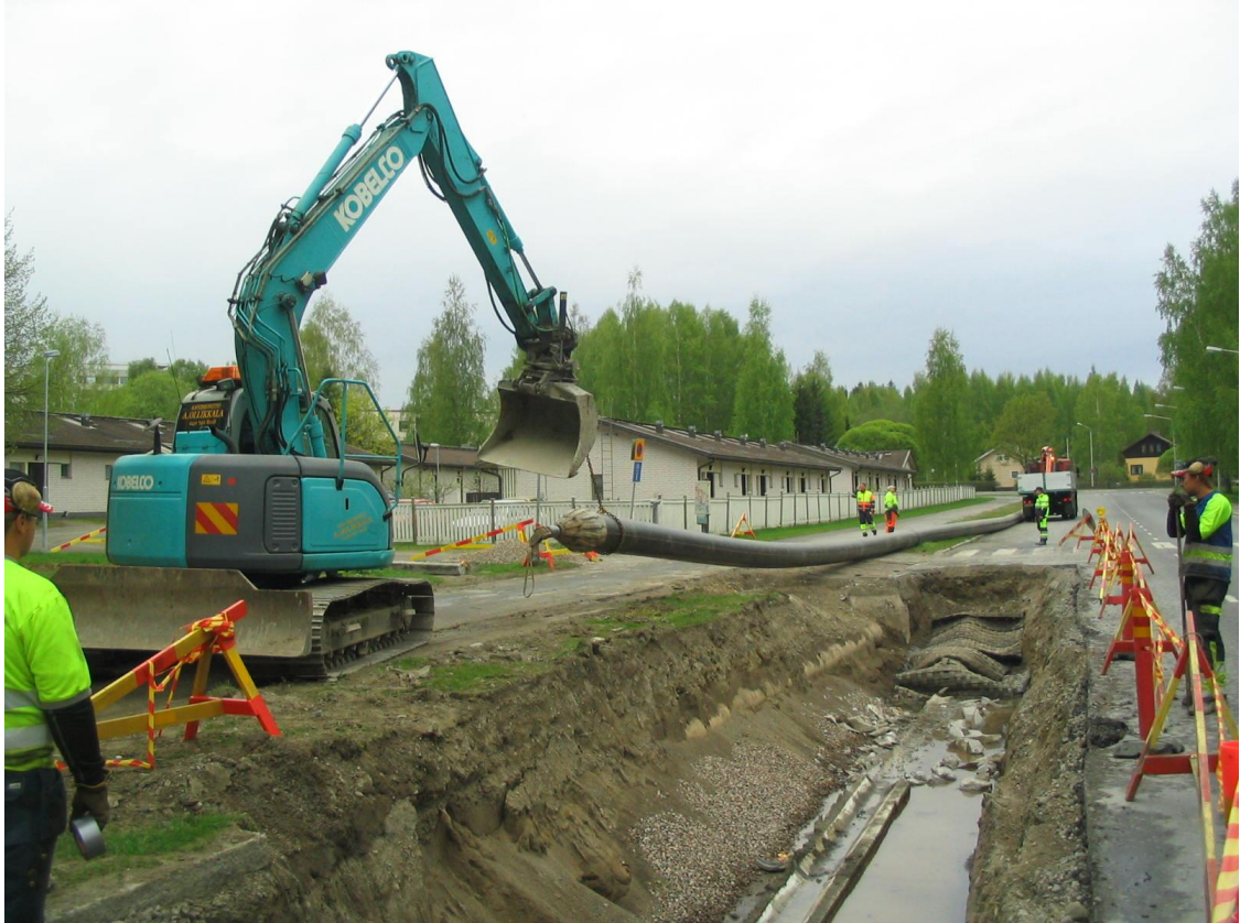
KUVA 12. Staattinen pakkosujutus (Sujutek)
