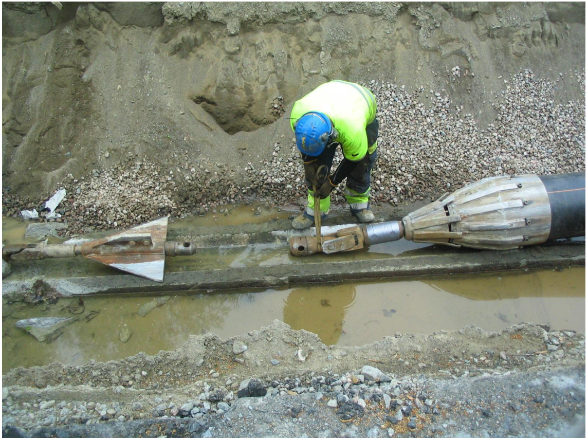
KUVA 13. Vasemmalla leikkuri, oikealla putken päähän kiinnitetty avennin (Sujutek)
