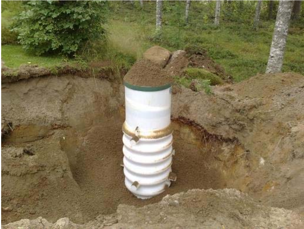
KUVA 3. Kiinteistökohtaisen pumppaamon asennus Haatajankylällä. Valokuva Timo Piirainen 2011.
