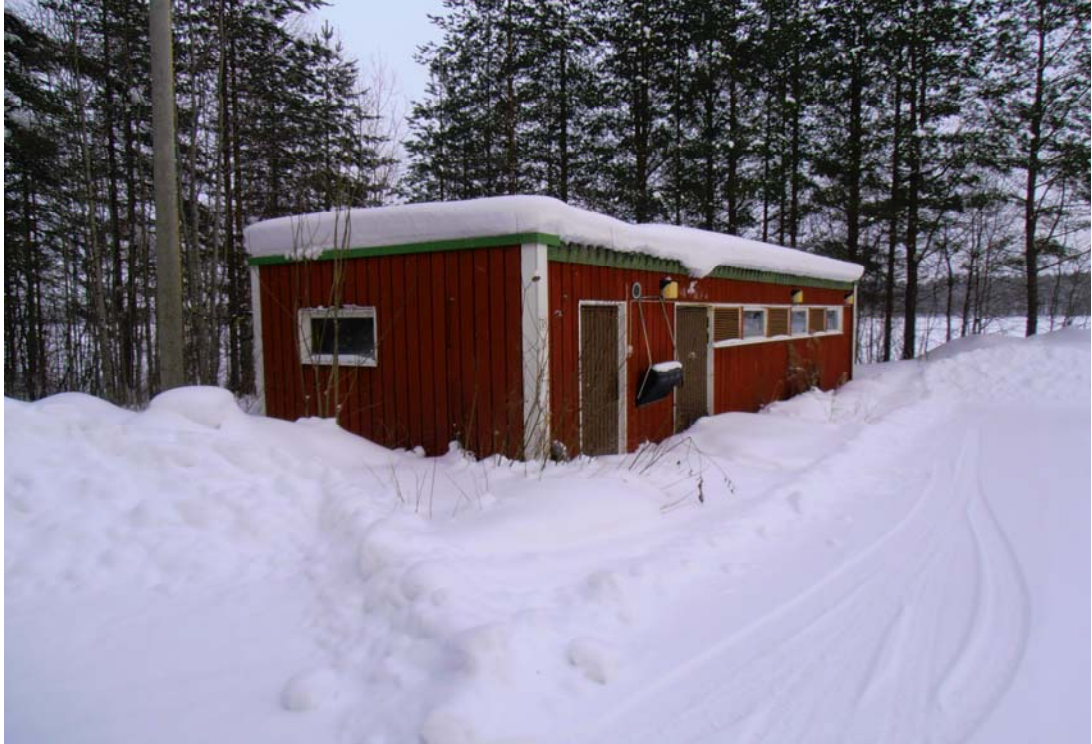
KUVA 5. Jämäksen nykyinen jätevedenpuhdistamo. Valokuva Tiia Tolonen 2012.
