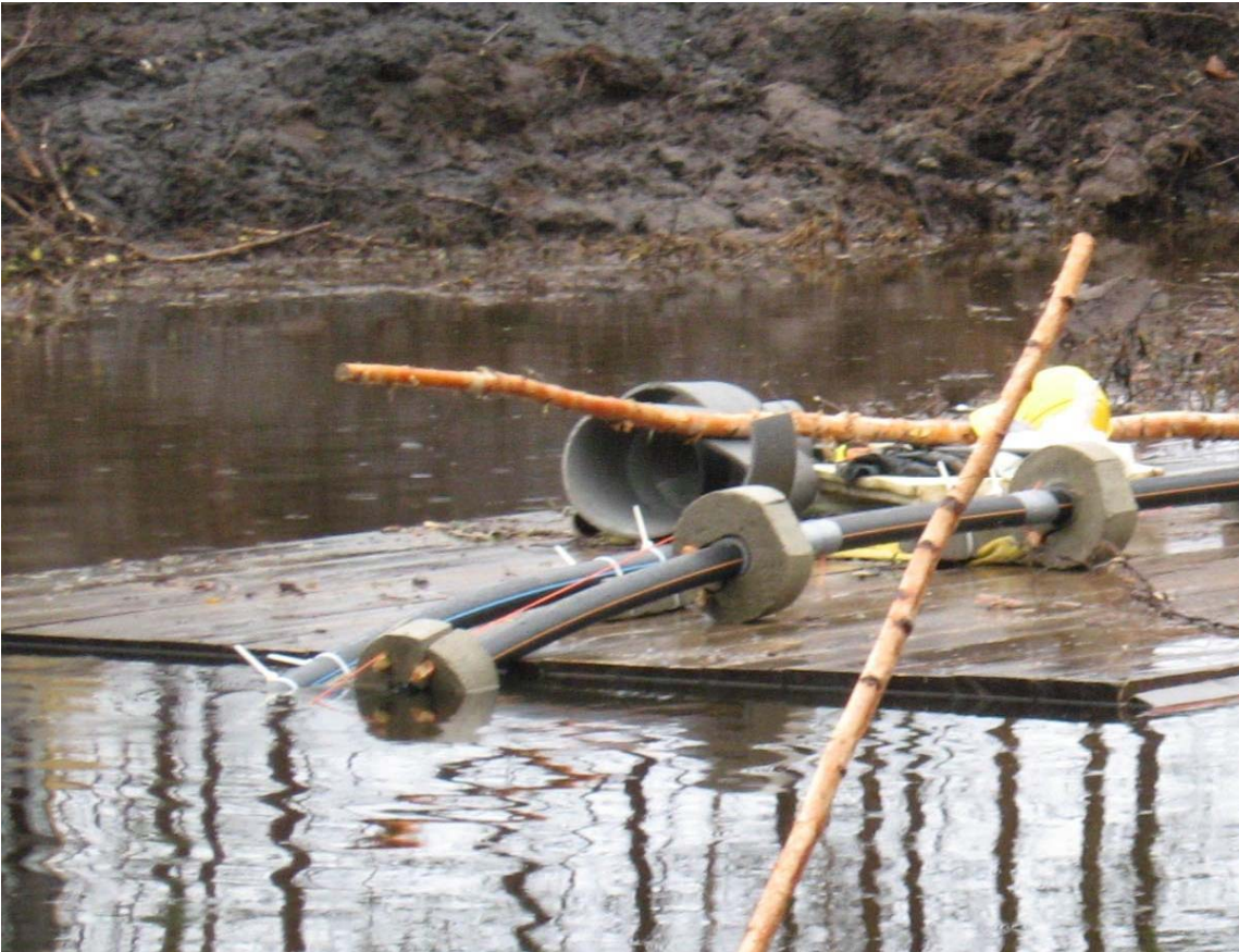
KUVA 2. Vesistön alitus. Putkien ankkuroinnissa käytetään betonipainoja. Valokuva Timo Piirainen 2011.
