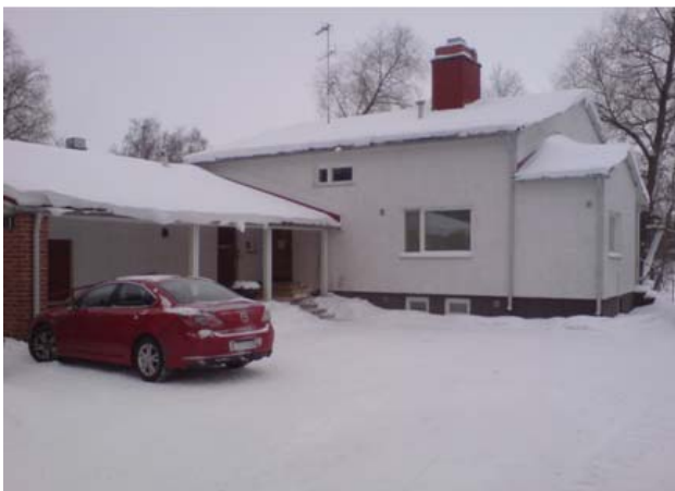
KUVA 5. Liperin seurakunnan toimistorakennus
