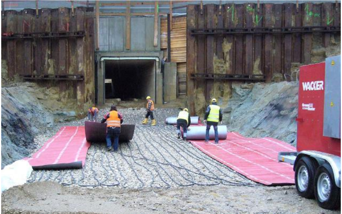
Kuvio 18. Valmistelevat työt ennen maaperän sulattamista.
