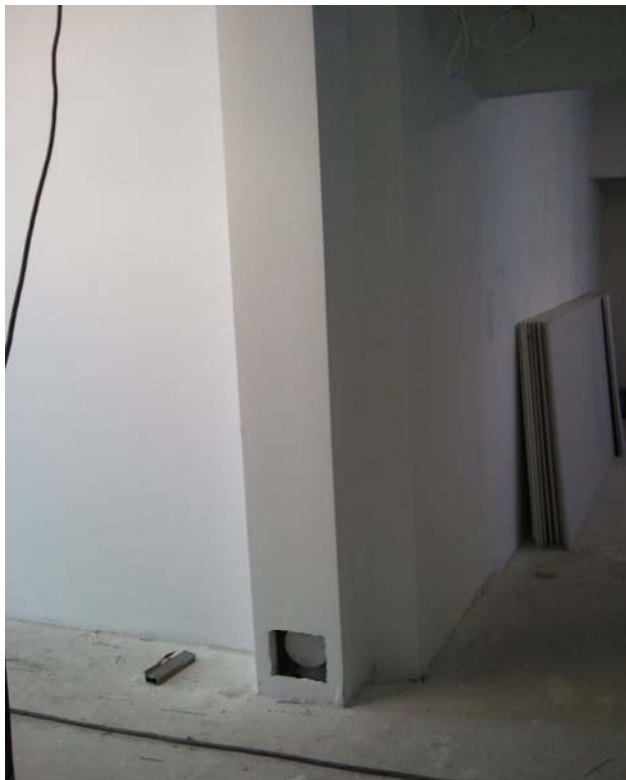
KUVA 6. Pystyviemärin tarkastusluukulle jätetty varaus.
