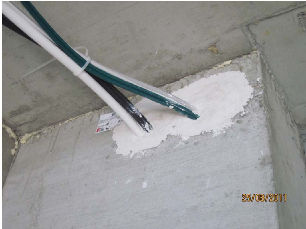
KUVA 9. Palokatko toteutettuna elastisella palomassalla
