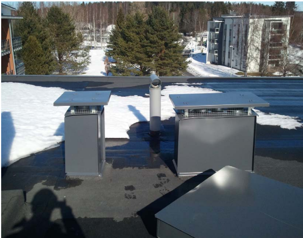
KUVA 8. Poistoilmakanavat pellillä suojattuna Asunto Oy Ylöjärven Sinisorsan katolla.
