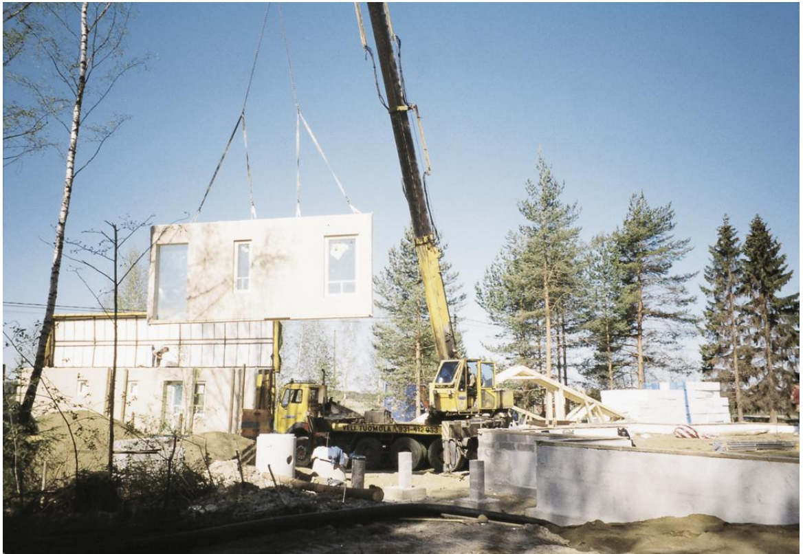
KUVA 5. Suurelementtien asennus. (Suomirakentaa.fi)
