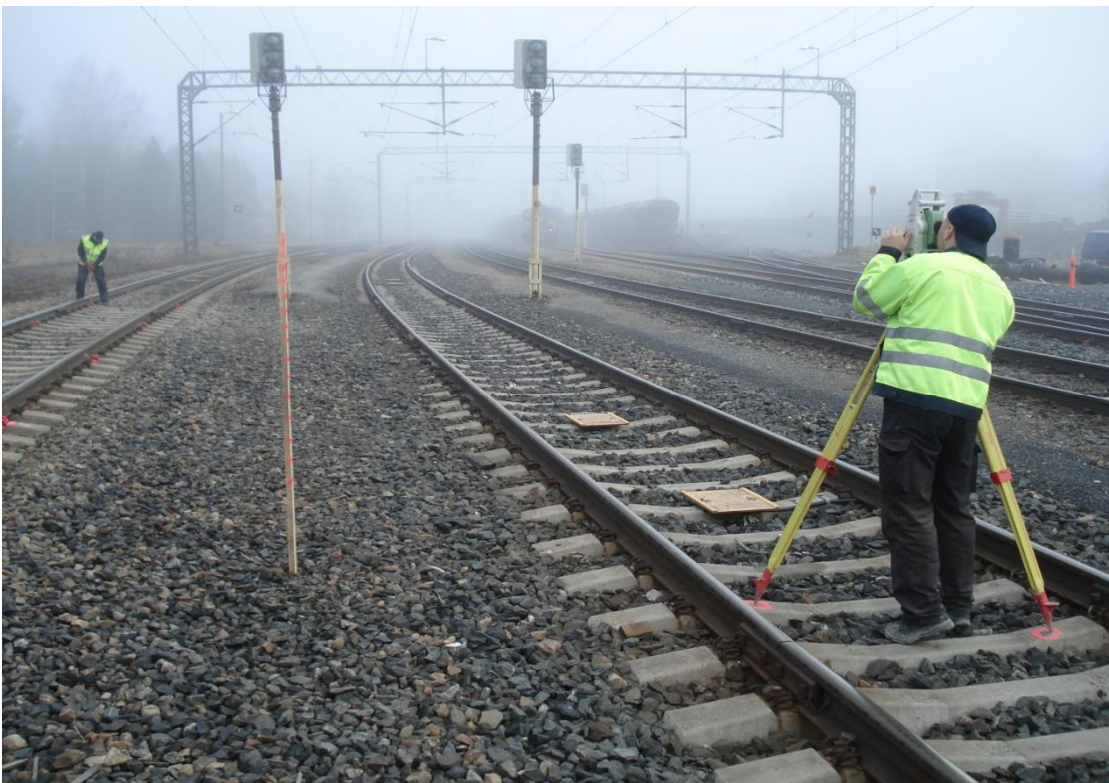
KUVA 3. Mittaustyötä ratapihalla, takymetrikalusto käytössä. Valokuva Kari Luukkonen 2008.
