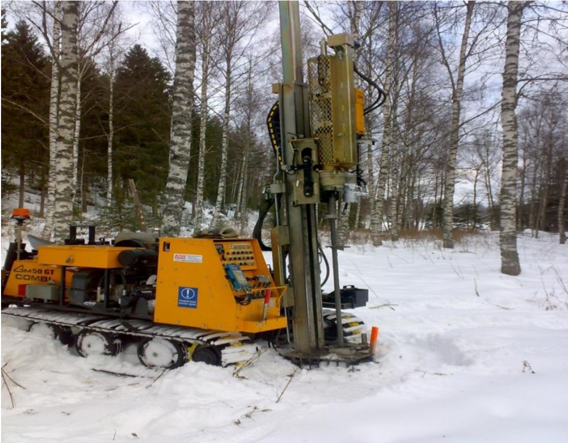
KUVA 2. Geoteknisiintutkimuksiin käytettävä monitoimikaira, heijarikairauskalusto käytössä. Valokuva Kari Luukkonen 2009.
