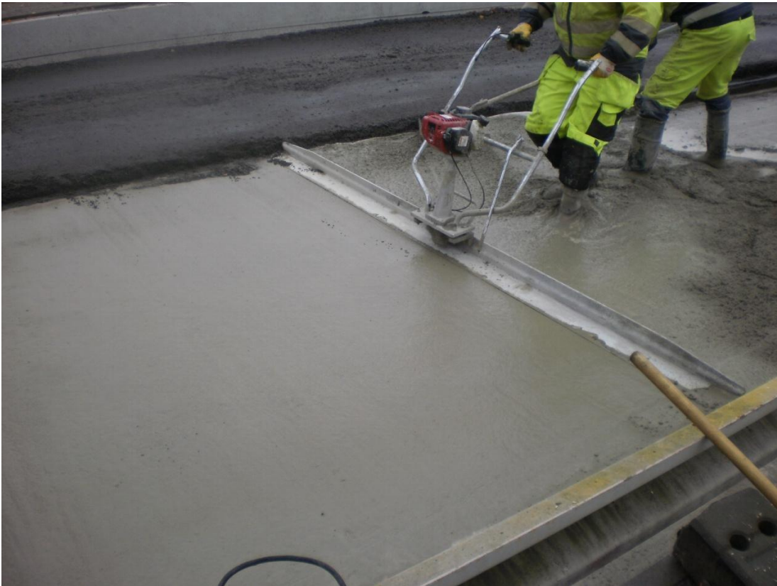
Kuva 1. Muotoiluvalu, massaa tiivistetään tärypalkilla ja betoni vibralla. Valokuva: Miika Riihimäki 2011.
