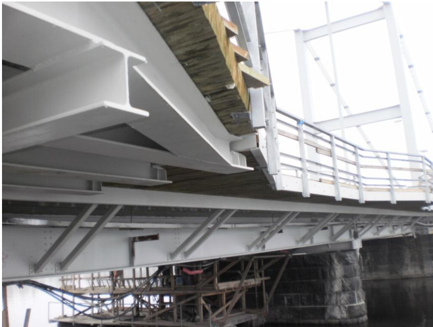
Kuva 6. Pintakäsiteltyjä teräspalkkeja ja puukantinen kevyenliikenteenväylä. Valokuva: Miika Riihimäki 2011.
