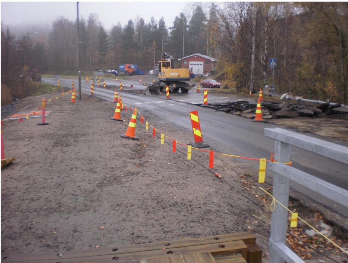
Kuva 7. Tulopenkereen korjausta. Valokuva: Miika Riihimäki 2011.
