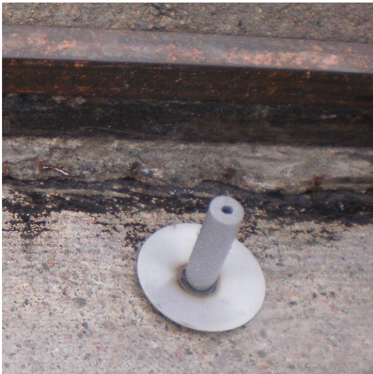
Kuva 5. Tippuputken terässuppilo, putki suojattu muotoiluvuoksi. Valokuva: Miika Riihimäki 2011.
