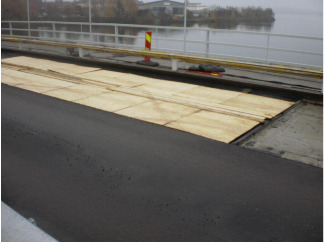
Kuva 2. Työaikainen vedeneristyksen suojaus vanerilevyillä. Valokuva: Miika Riihimäki 2011.
