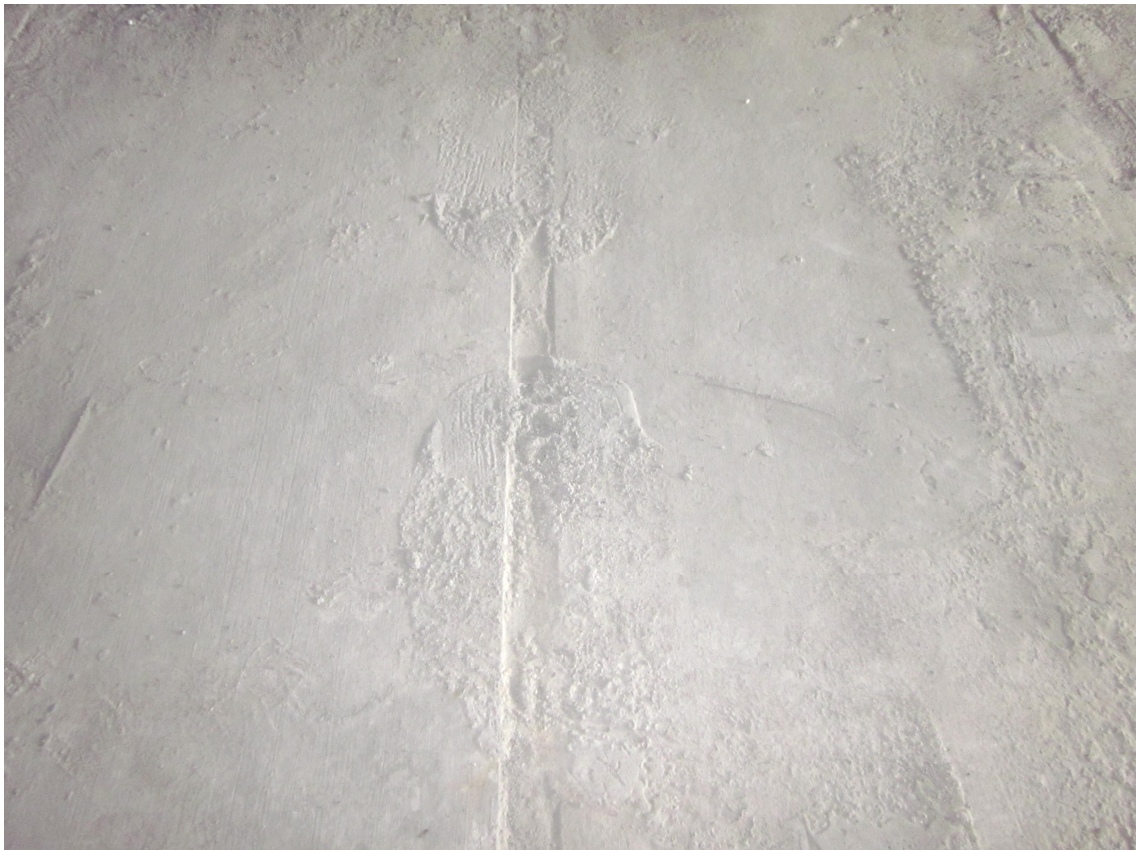
Kuvio 3. Ontelolaatan pinnalle on jäänyt saumavalussa roiskeita, jotka voivat heikentää lattiatasoitteen tartuntaa.
