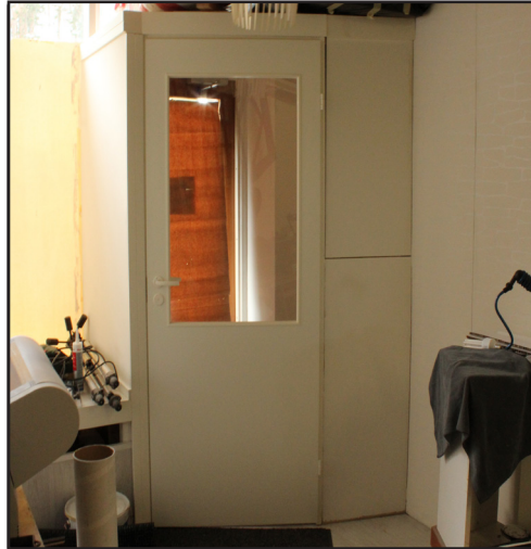
Tuulikaappi eristää kylmyyden ja katupö- lyn pääsyn myymälään ja työpajaan
