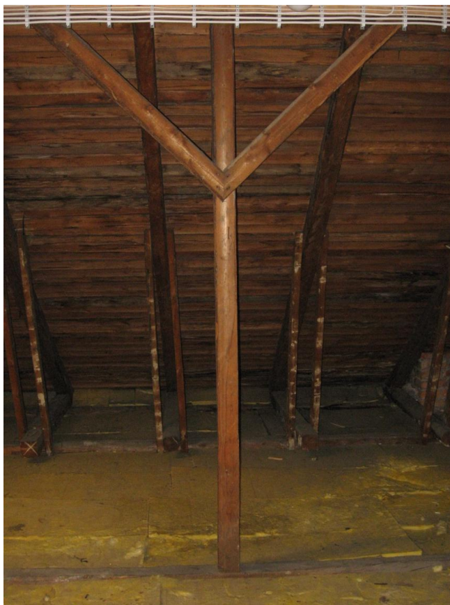
Kuva 5. Esimerkki vesikaton kantavasta rakenteesta.
