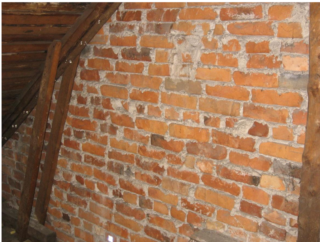
Kuva 4. Vanha tiilestä muurattu palomuuuri.
