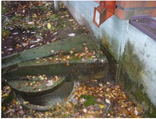
KUVIO 7. II-talon vedenpoistojärjestelmä tulisi tarkistaa ja korjata
