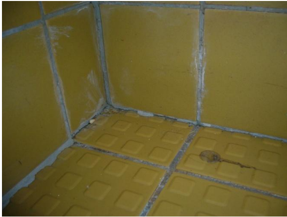
KUVIO 41. Saunan laatoituksen saumat aukeilleet
