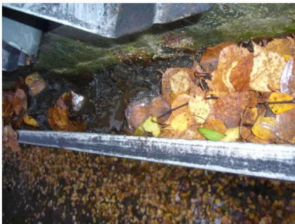
KUVIO 15. Autokatoksen sadevesikourujen tulisi tehdä säännöllisesti
