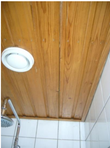
KUVIO 39. Kattopaneelit ovat irtoilleet
