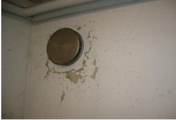
KUVIO 45. Seinämaali on lohkeillut mahdollisesti kosteuden takia
