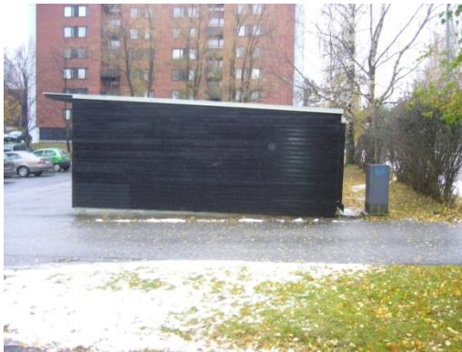
KUVIO 8. Maanpinta viettää autotallirakennusta kohti
