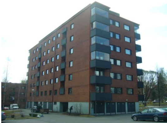
KUVIO 5. Pysäköintialueen vedenpoistossa ei ollut huomautettavaa
