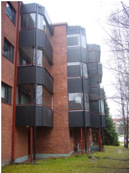
KUVIO 20. Ulkoseinien pinnat ovat yleisesti hyvässä kunnossa
