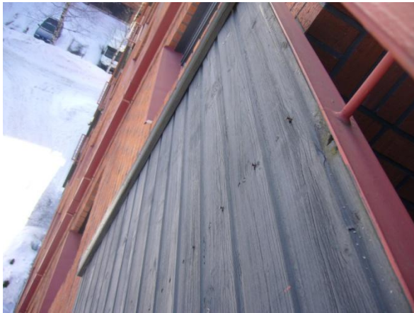
KUVIO 19. Laudoitusten naulaukset tuuletusparvekkeilla ovat löystyneet
