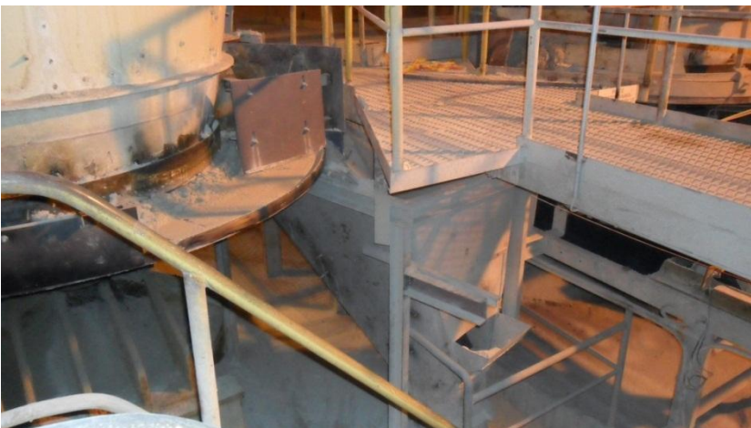
KUVA 12. FHT Apatiittisiilojen työtaso. (valokuva Anssi Hakkarainen)
