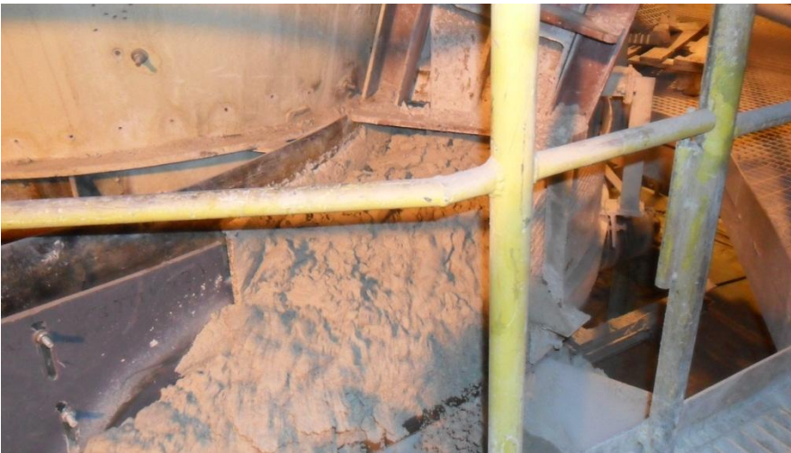
KUVA 9. Apatiittisiilo purkuluukku. (valokuva Anssi Hakkarainen)
