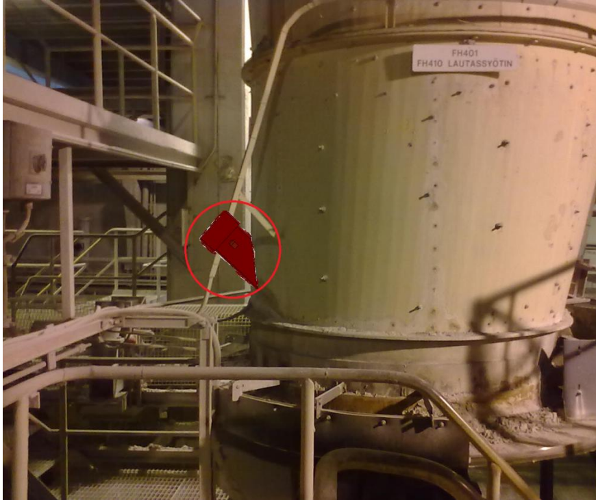
KUVA 21. FHT lautassyöttimen 401 suppiloon tuleva piikkausaukko. (kuva Anssi Hakkarainen)
