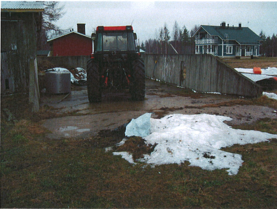
KUVIO 7. Kuvassa näkyy nykyinen lantala, jota on tarkoitus laajentaa oikealle päin. Virtsakaivo on maan sisässä oikealla olevan seinän molemmin puolin.
