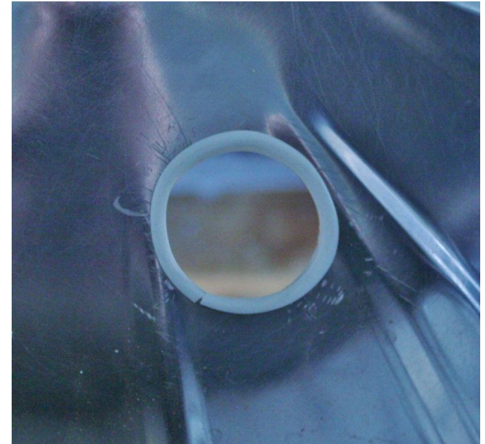
Kuva 22: Valosarjan johtojen läpivienti suojattuna.
