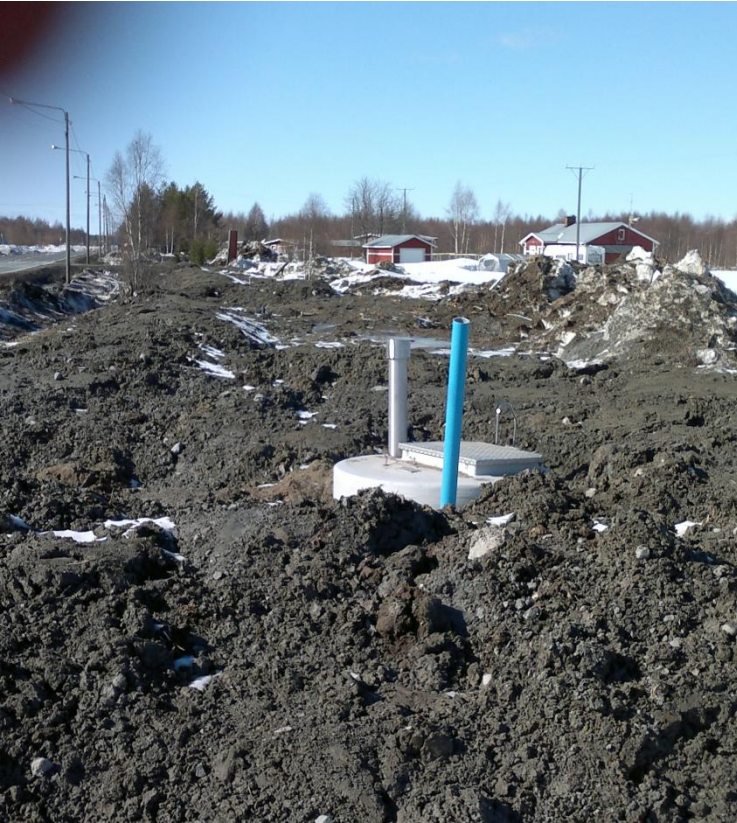
Kuva 1 Viemäröintihankkeen rakentamista Vojakkalassa. Kuvassa on yksi runkoviemärin pumppaamoista. Kuva Hanna Liisanantti
