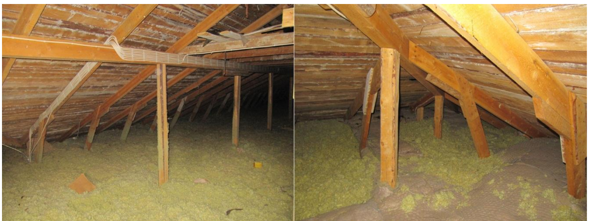
Kuva 18. Lähdekodin Aamuruskon yläpohjassa oli hyvin tuuletusreikiä, eikä rakenteissa näkynyt merkkejä kosteusvaurioista
