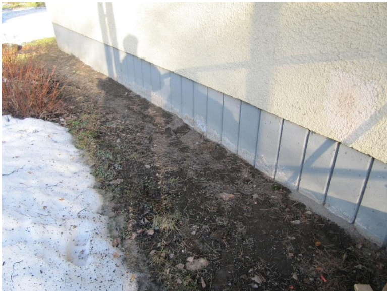
Kuvio 3. Laajennusosan sokkeli
