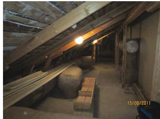
Yleiskuva keittiön ullakolta.
