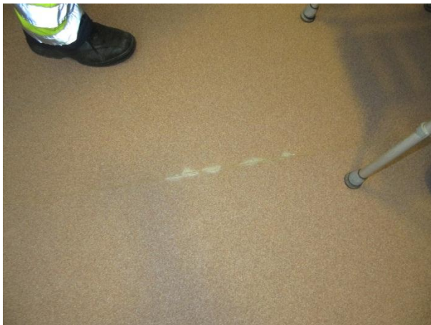
Kuva 27. Saarikodin pesuhuoneen lattiamaton sauman ympäristö on märkä neliön kokoisella alueella (100% RH)
