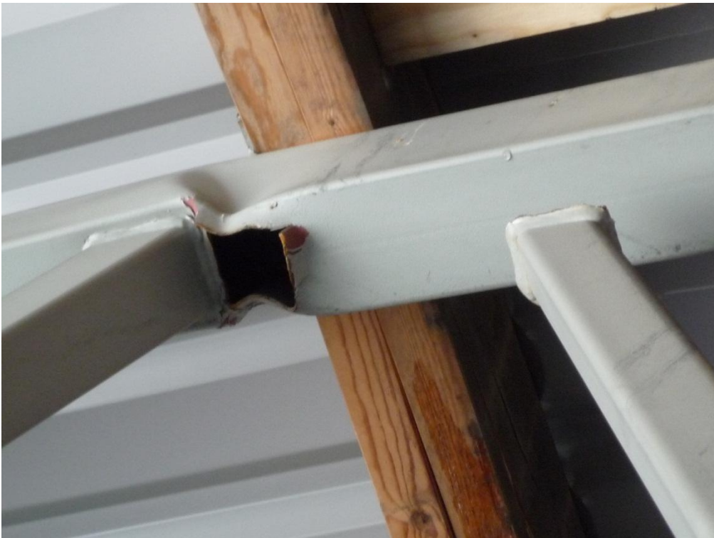
KUVA 19 Leikkauslävistyminen yläpaarteen K-liitoksessa.
