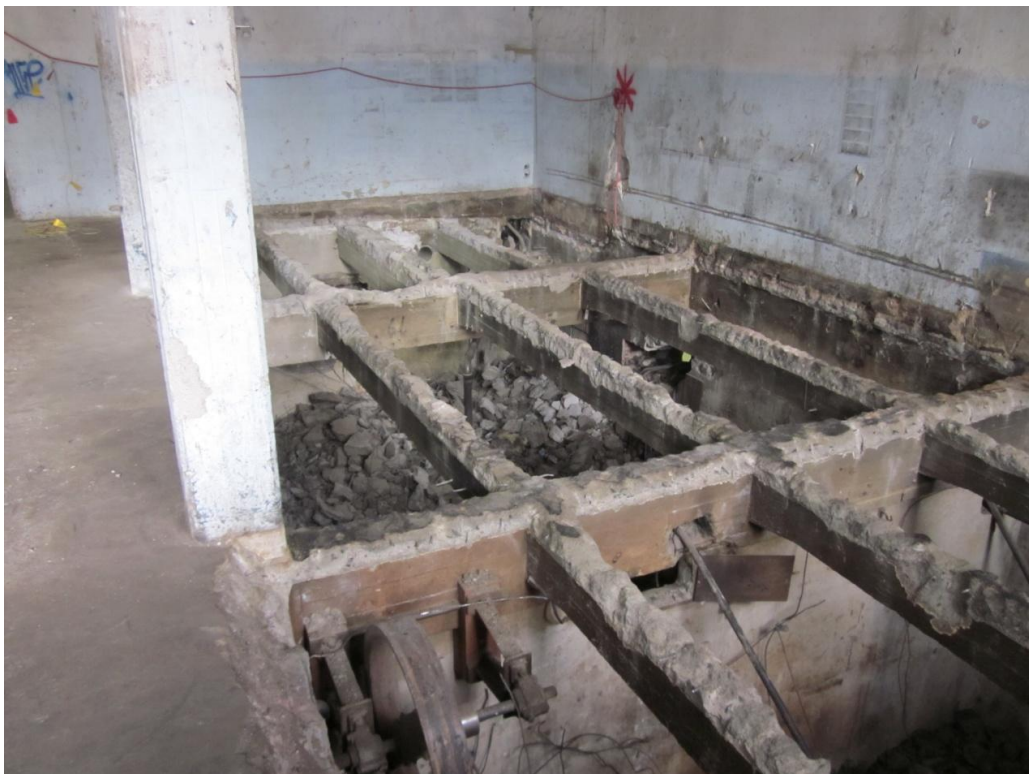
Kuva 13. 1-kerroksen välipohjan purkutyö on valmis.
