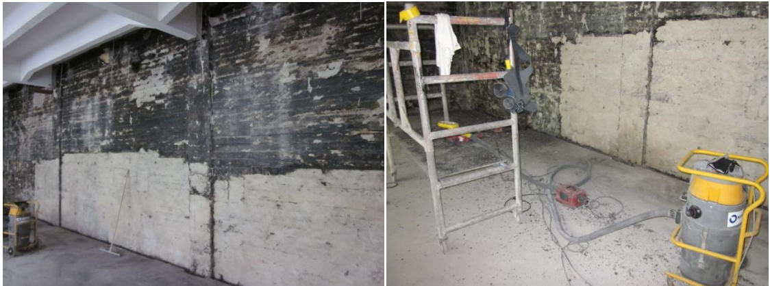
Kuva 18. Kuvassa on puhdistettua seinää ja imurikalustoa.
