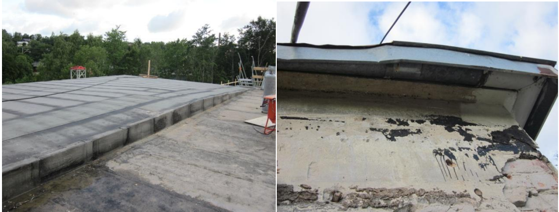
Kuva 15. Kuvassa idän puoleisen rakennusosan vesikattorakenteita.
