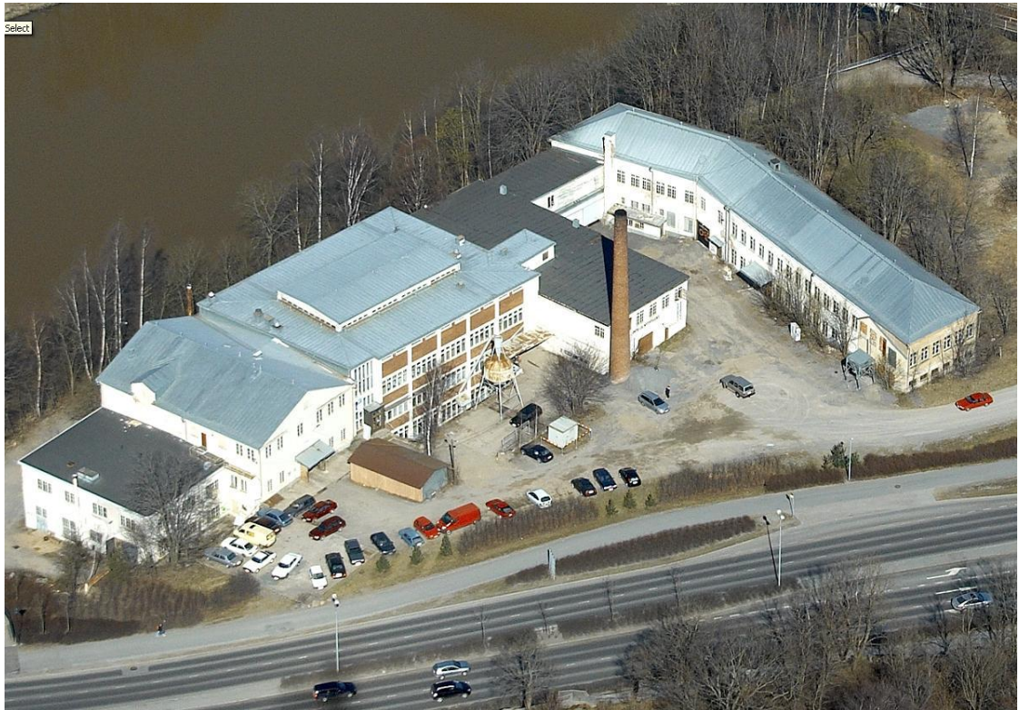
Kuva 11. Ilmakuva ennen purkutöiden aloitusta.
