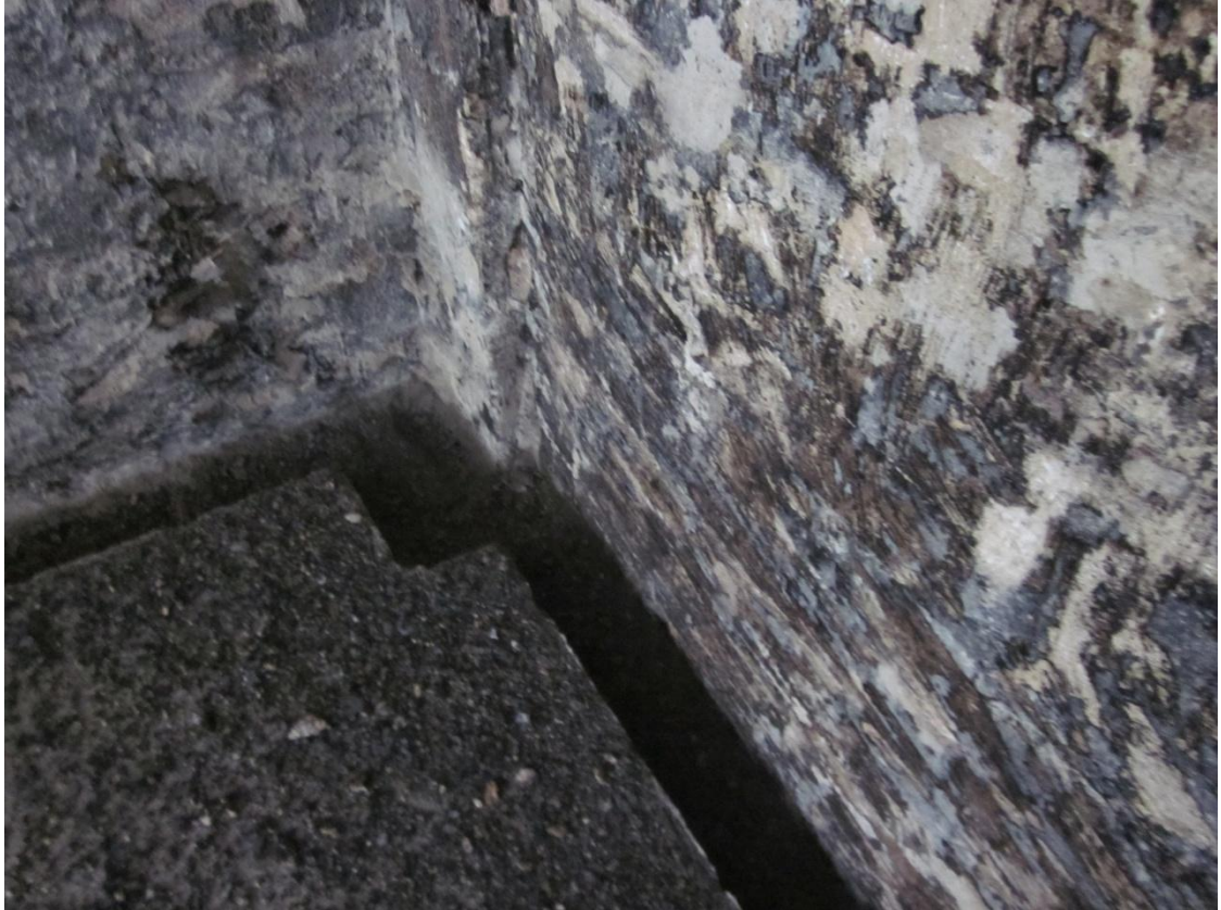
Kuva 6. Kreosottipitoisella pikimassalla sivelty ulkoseinä.
