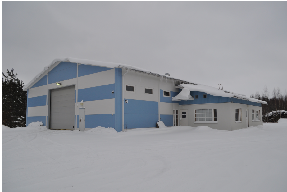
Kuva 4. Kevee Oy:n nykyiset toimitilat
