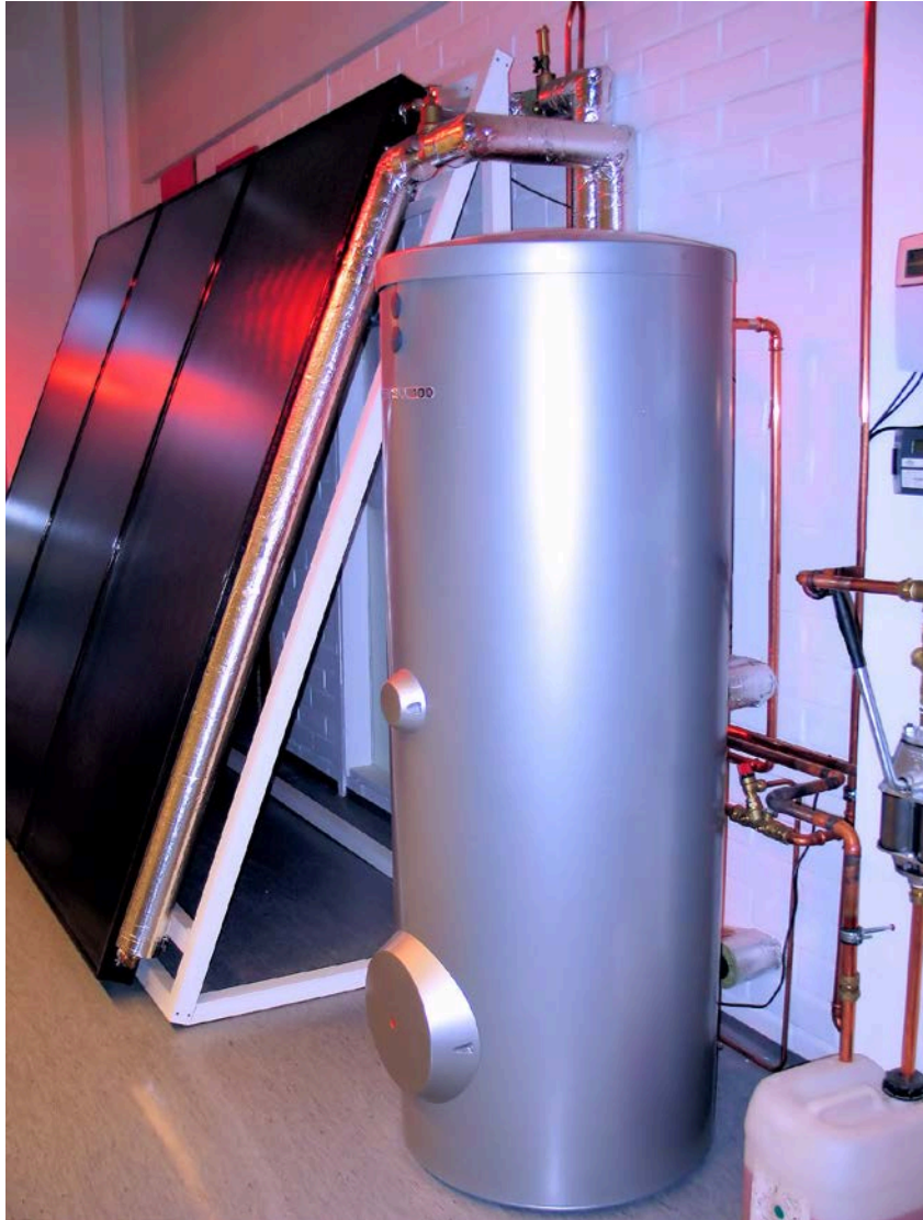
KUVIO 11. Vitocelli -aurinkolämpövaraaja ja aurinkokeräin
