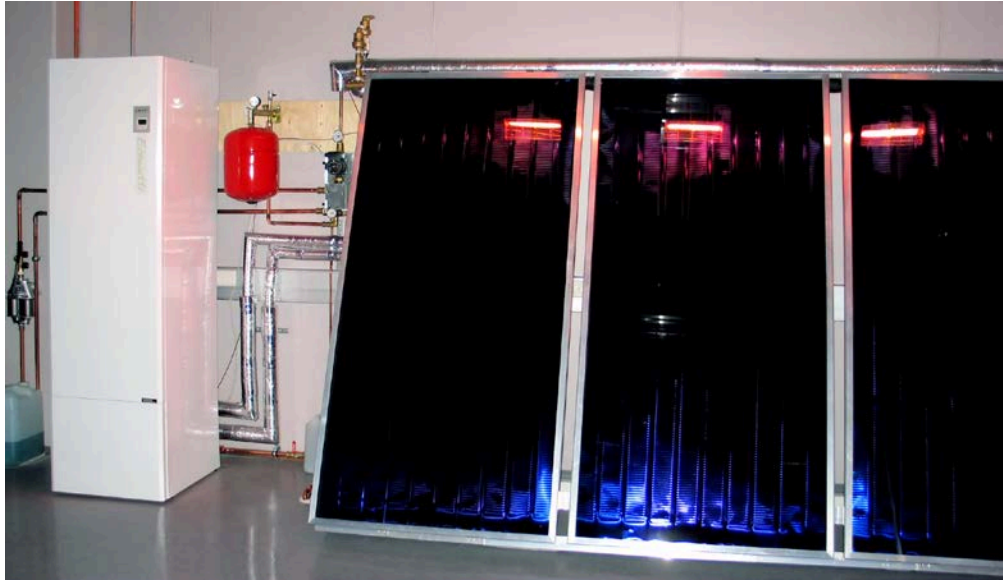
KUVIO 10. Ekowatti -aurinkolämpövaraaja ja aurinkokeräin
