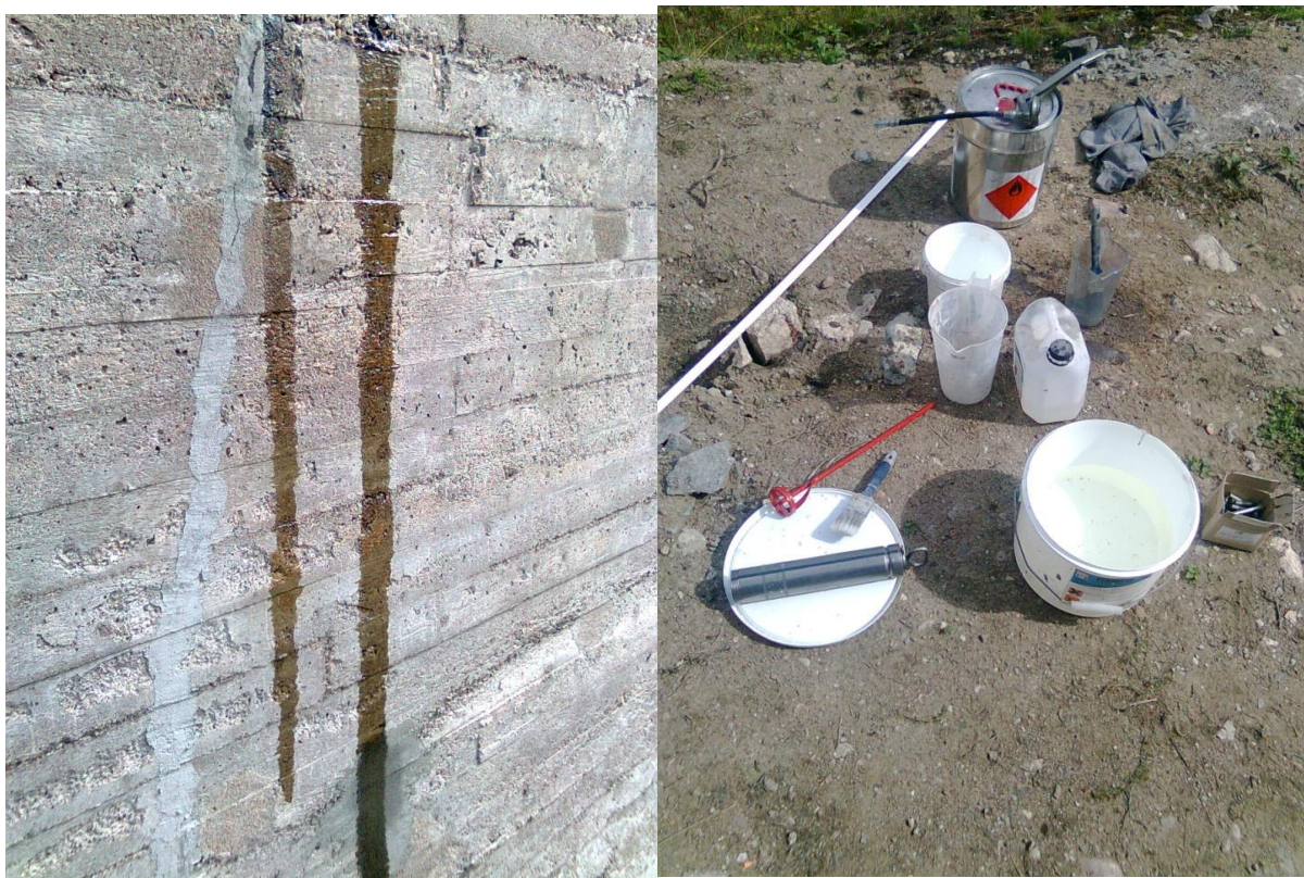
Kuva 30. (vas.) Halkeamista seinän läpi tullutta injektointimassaa. Kuva 31. (oik.) Injektointitarvikkeita.
