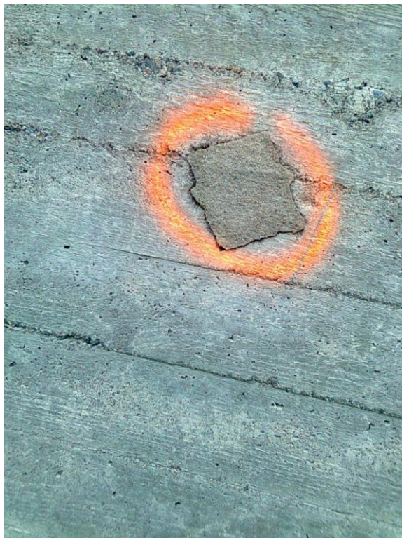
Kuva 5. Vanha paikka merkattu vesipiikattavaksi.
