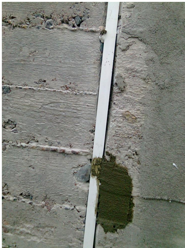
Kuva 35. Liikuntasamaan liimattu muovilista ja paikattu lohkeama.
