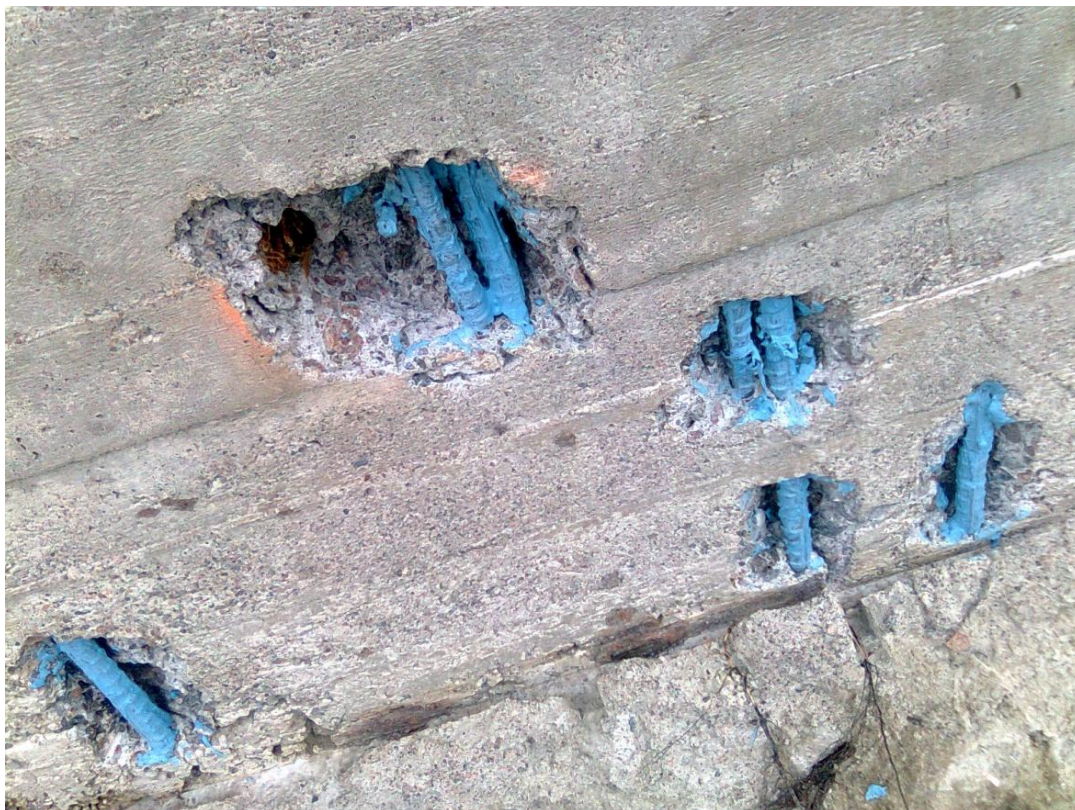
Kuva 16. Korroosiosuojattu teräksiä.
