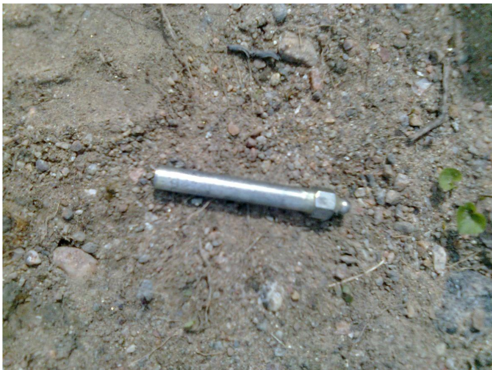
Kuva 29. Injektoinnin jälkeen mansetin päähän asennettava holkki.
