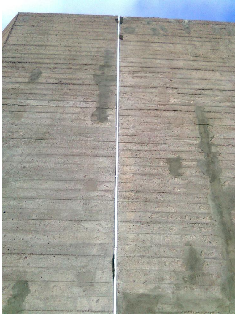
Kuva 37. Liikuntasaumaan koko vallin korkeudeltaan asennettu muovilista.
