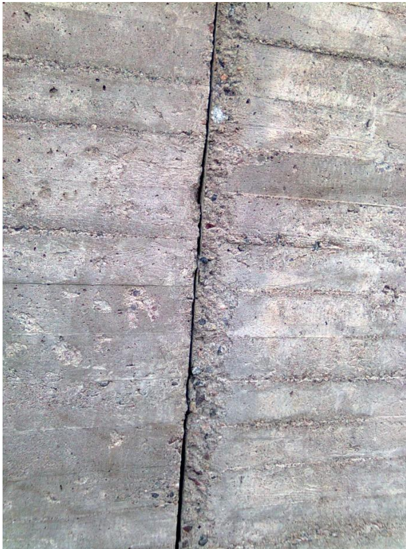
Kuva 32. Vanha liikuntasauva.
