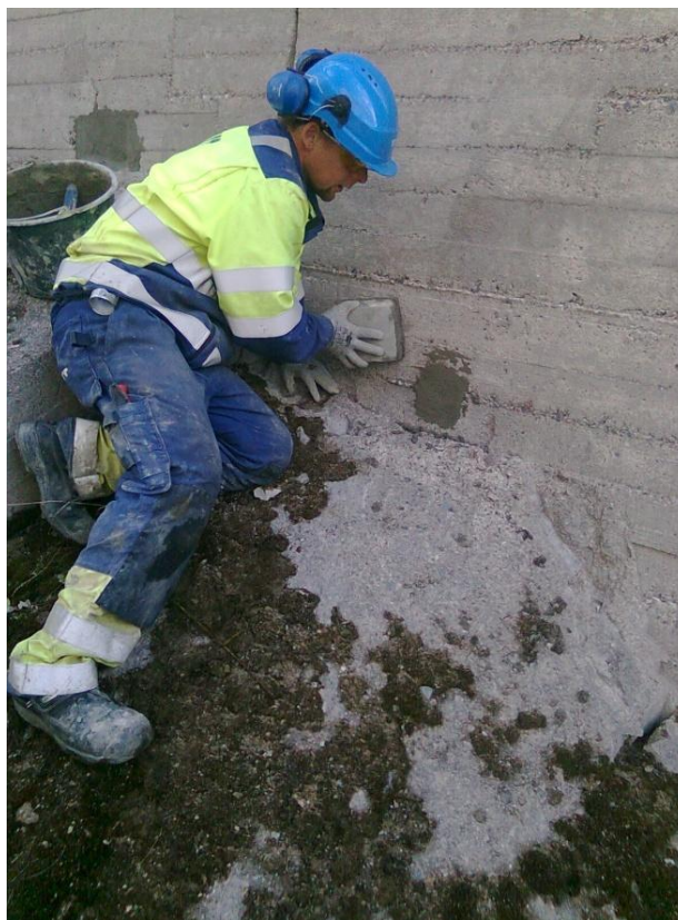
Kuva 21. Korjauslaasti laitetaan korroosiosuojauksen jälkeen ja pinta hierotaan sileäksi.
