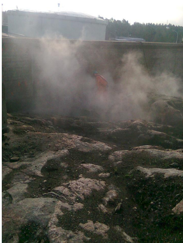
Kuva 9. Vesipiikkausta vallin sisäpuolella.
