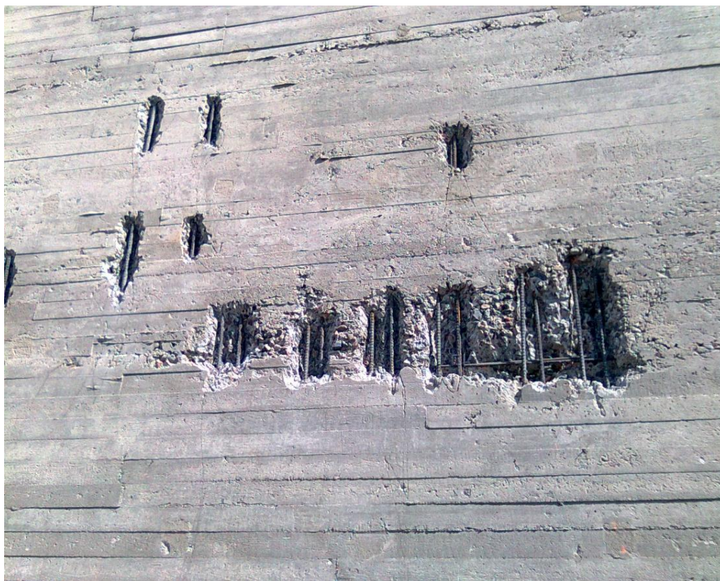
Kuva 10. Esille vesipiikattuja teräksiä.
