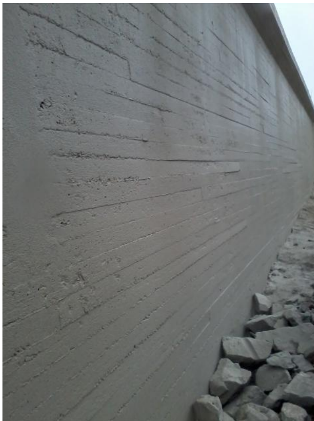
Kuva 39. Valmiin muurin pintaa.
