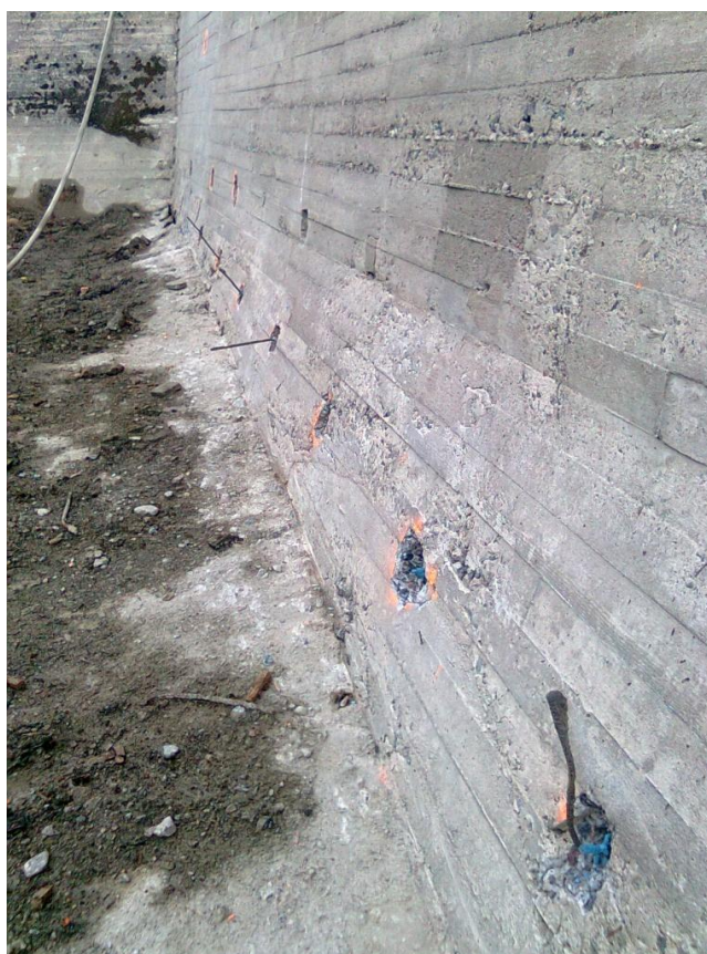
Kuva 14. Paremmin esille vesipiikattuja teräksiä.
