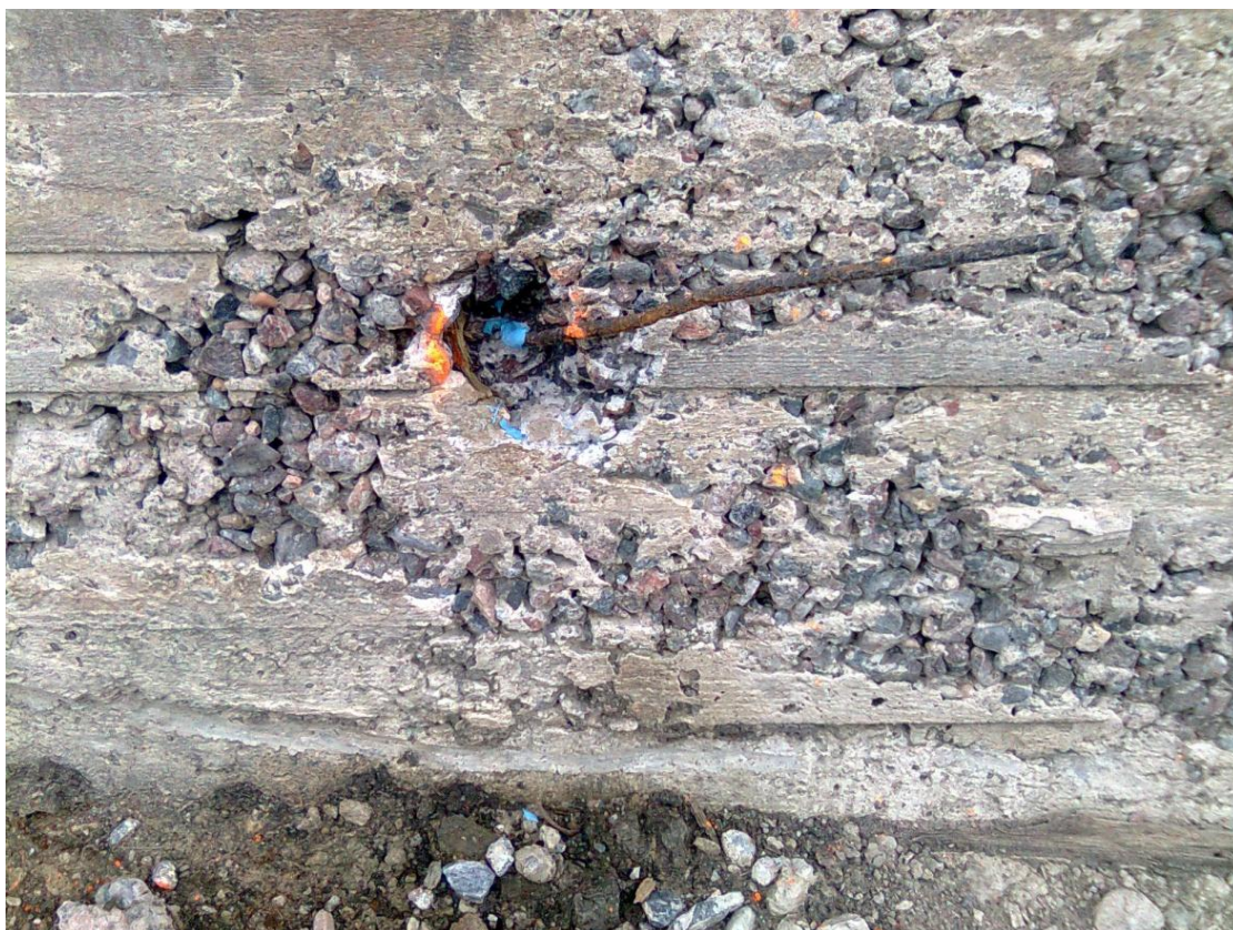
Kuva 20. Vesipiikkaus paljastaa muurin koostumuksen.
