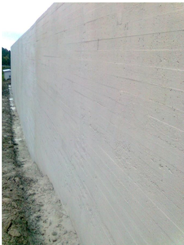
Kuva 40. Kahteen kertaan pinnoitettu, valmiiksi saneerattu muuri.
