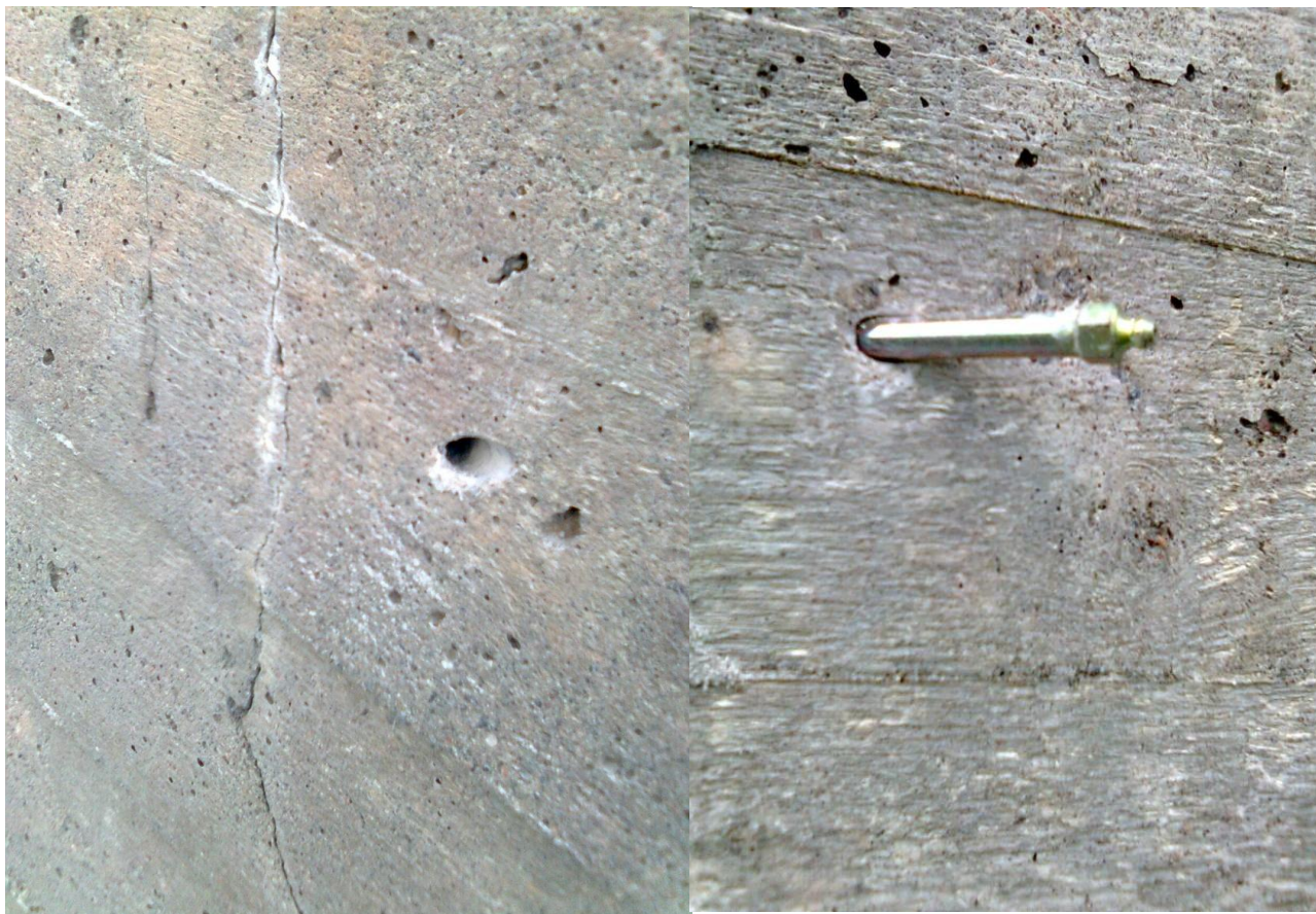
Kuva 26. (vas.) Injektointia varten porattu viistosti reikä. Kuva 27. (oik.) Injektointi tehty.
