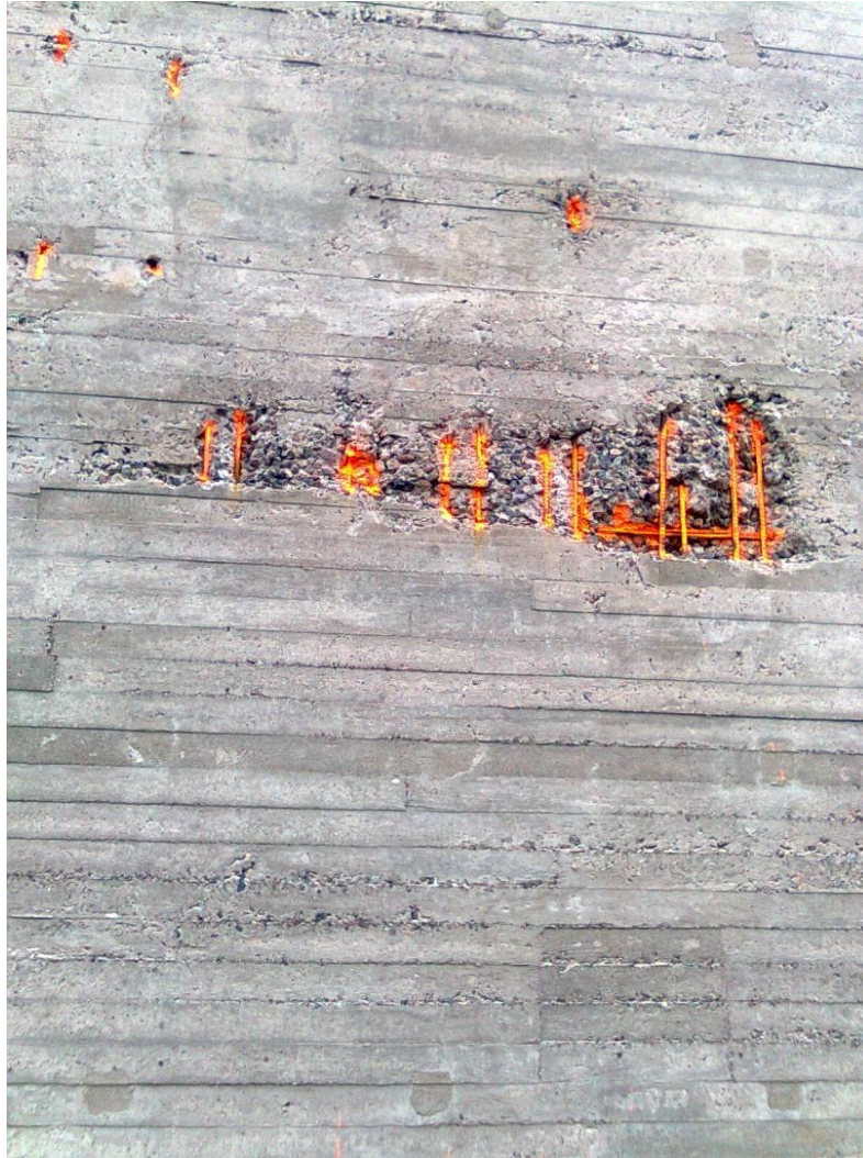
Kuva 15. Kohdat merkattu lisäpuhdistusta varten
