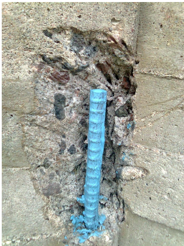
Kuva 17. Korroosiosuojattu teräs.
