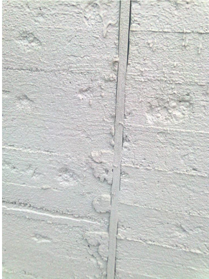
Kuva 41. Valmis pinta liikuntasäuran kohdalta.
