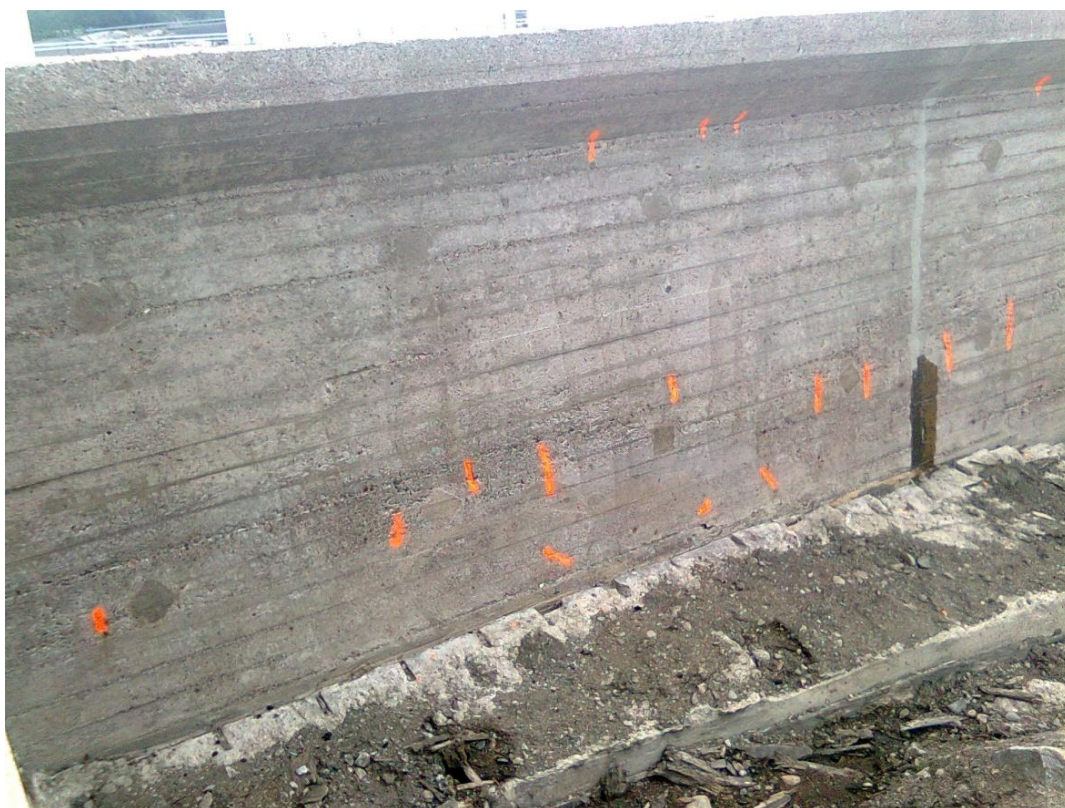
Kuva 6. Oranssit kohdat vesipiikataan.
