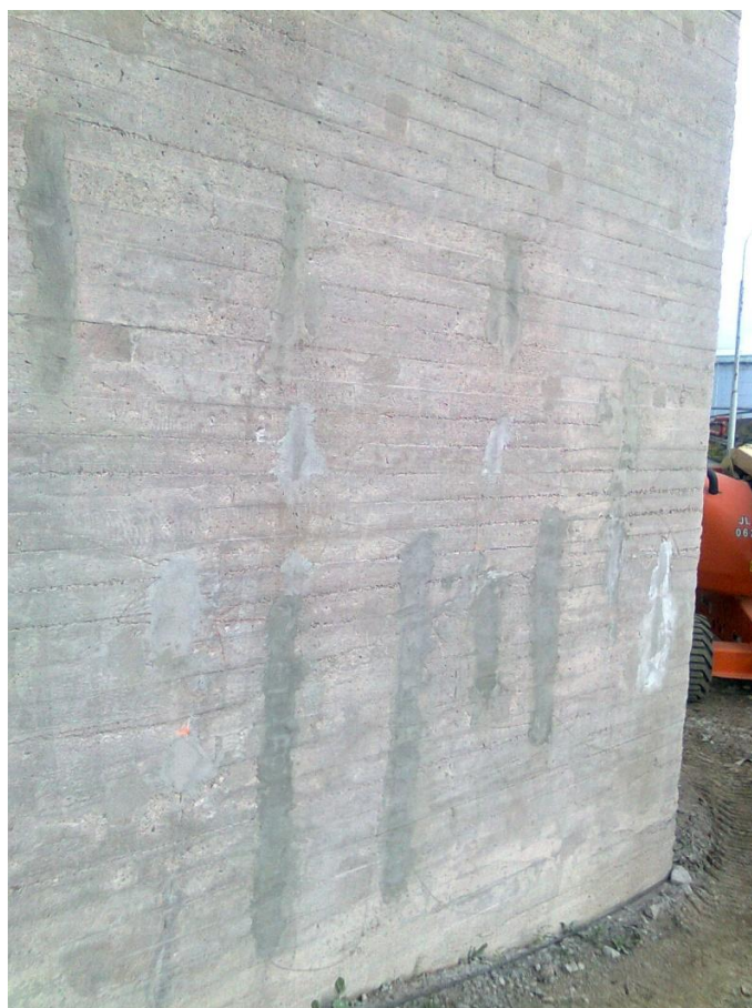
Kuva 25. Paikattu vallin ulkokulma.
