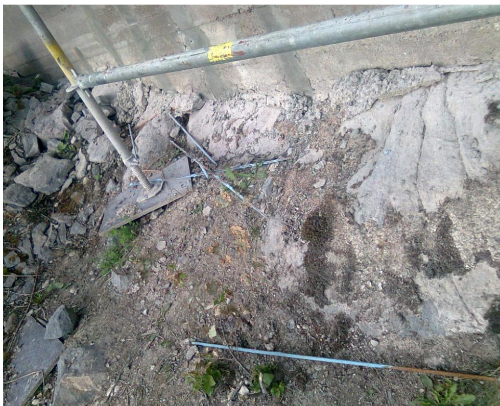
Kuva 19. Vesipiikkauksen katkomia teräksiä.
