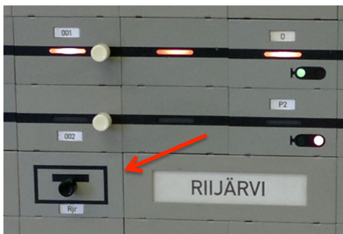
Bild 19. Bahnhofstaste auf dem Stelltisch
