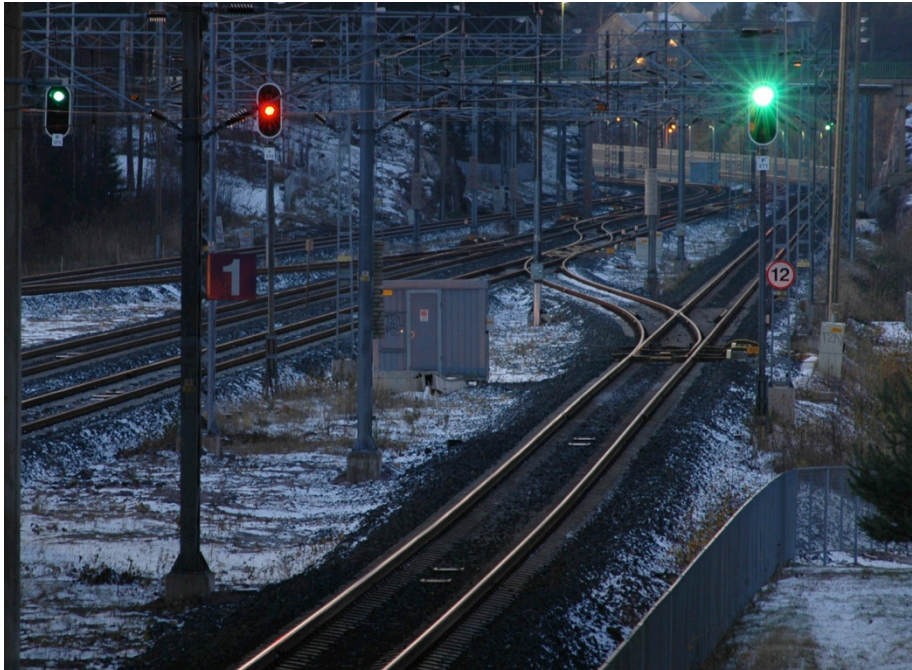
Bild 2. Hauptsignale des alten Signalsystems und neue Vorsignale (hinten)
