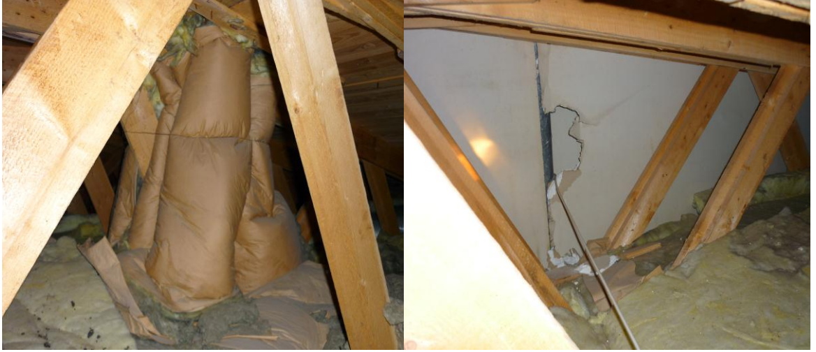
Kuvio 6. Ilmastointiputken sekä antennijohdon läpiviennit.
