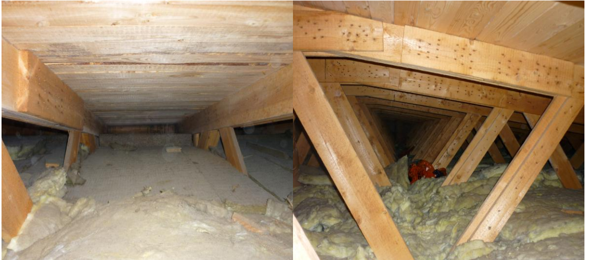
Kuvio 7. Vesikaton ponttilaudoitus sekä ullakkotila.
