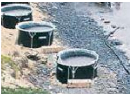
Kuva 14. Siirrettävän puskurialtaan käyttöä keräyspisteessä (IPIECA 2008).
