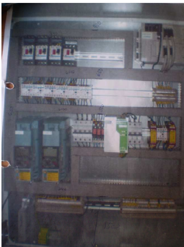
Figur 41. Komponenterna i gamla centralen.
